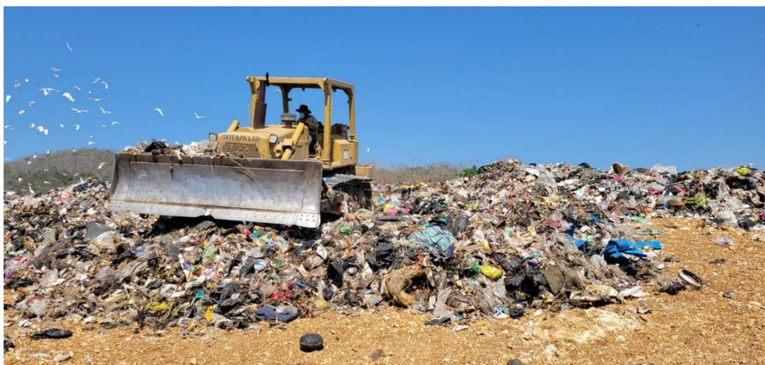
**Figura 2.** Zona de compactación de los RSU que llegan al SDF.
