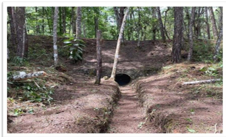
Imagen 15. mantenimiento correctivo del lugar.
