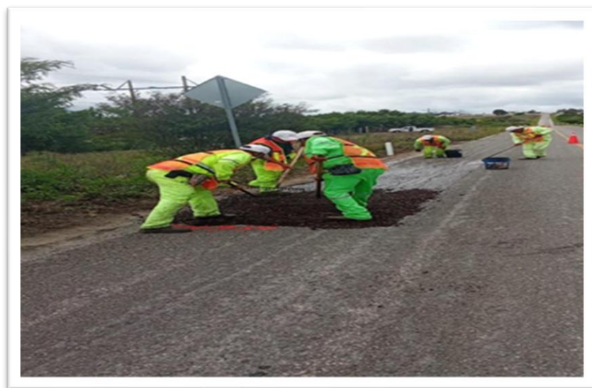
Imagen 18. Bacheo superficial con personal capacitado. Fuente: Gutiérrez, 2025.
