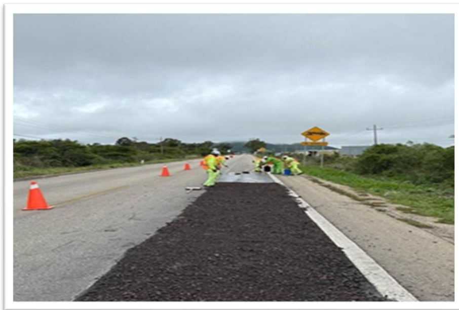
Imagen 19. Renivelación del camino en puntos específicos. Fuente: Gutiérrez, 2025.
