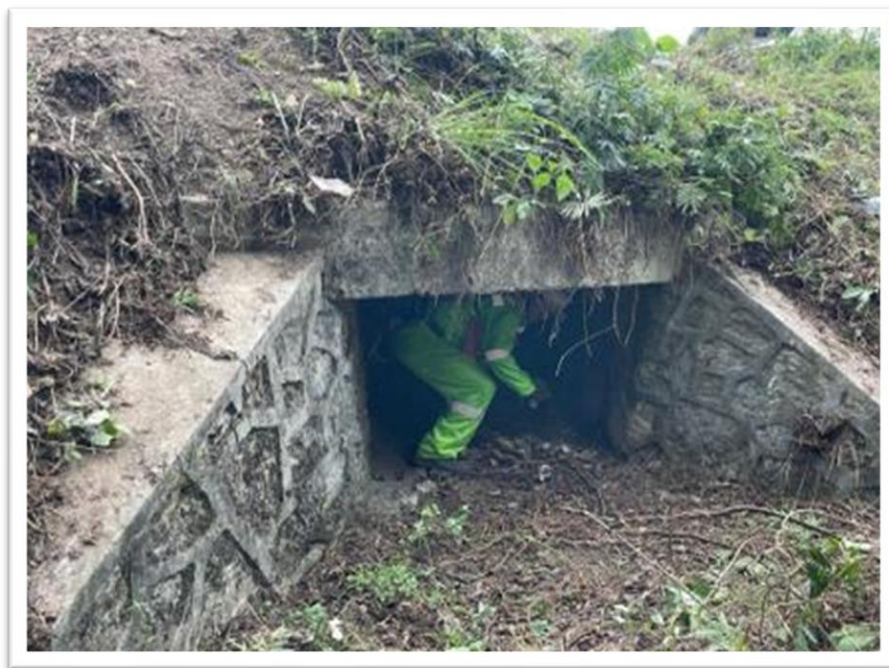
Imagen 12. Limpieza y desazolve de alcantarillas.
