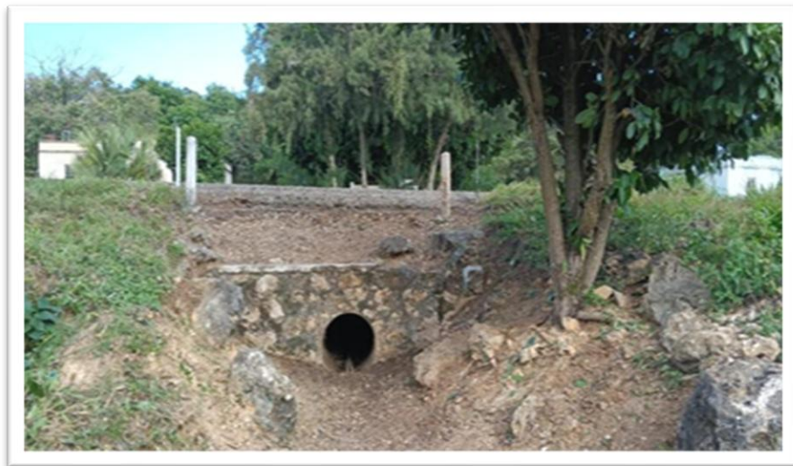
Imagen 14. Mantenimiento preventivo del lugar.
