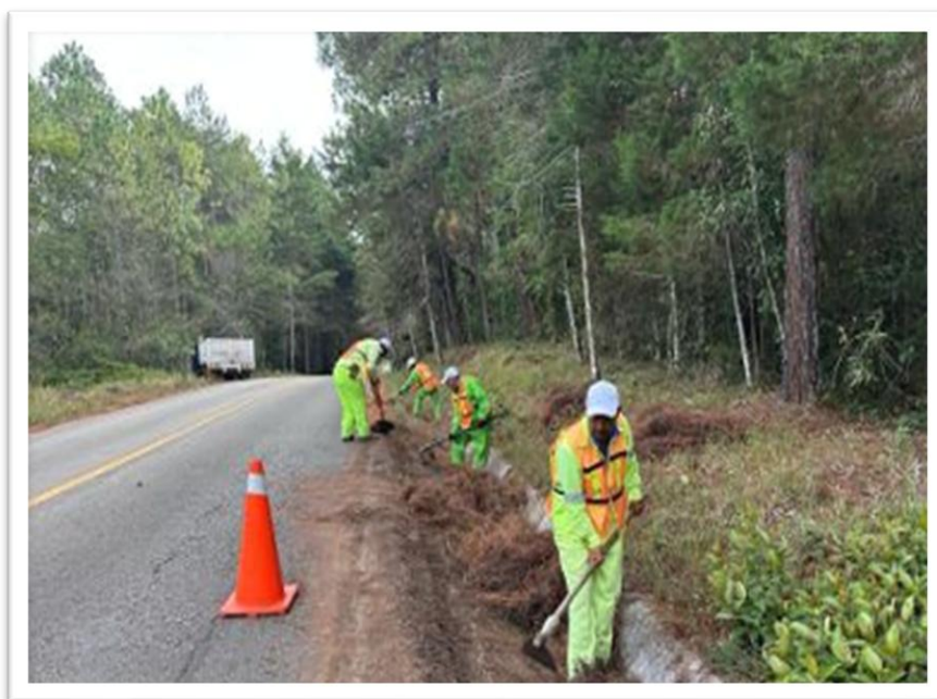
Imagen 11. Mantenimiento preventivo de cunetas.
