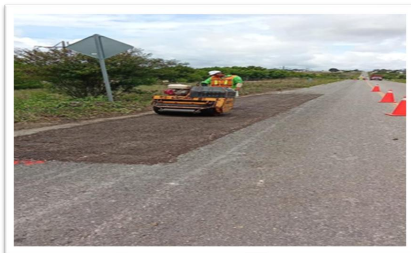
Imagen 17. Bacheo superficial con maquinaria correspondiente. Fuente: Gutiérrez, 2025.
