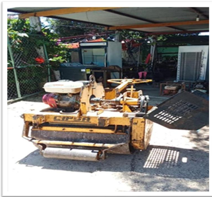
Imagen 25. Maquinaria utilizada para el bacheo.
