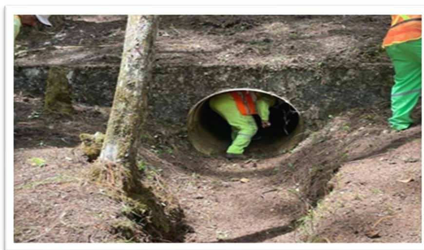
Imagen 13. Limpieza manual de canales.
