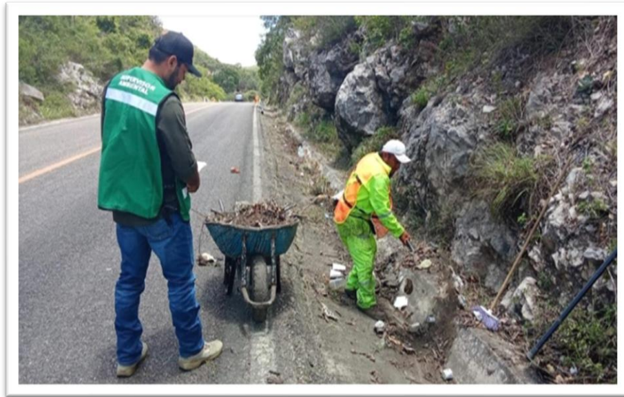
Imagen 5. mantenimiento de sistemas de drenaje. Fuente: Gutiérrez, 2025.
