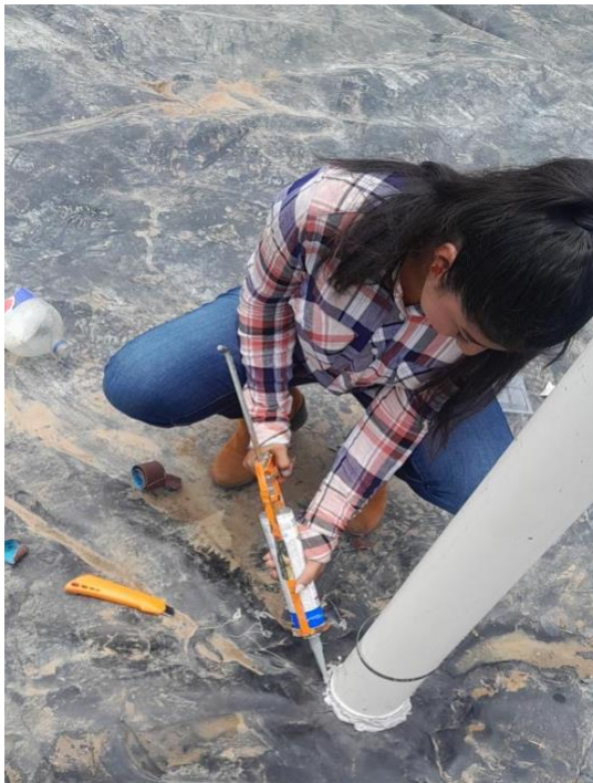
Instalación del tubo de filtración de PVC
