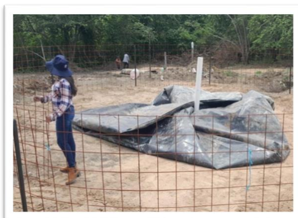
Figura 21. Instalación del estanque de geomembrana.
