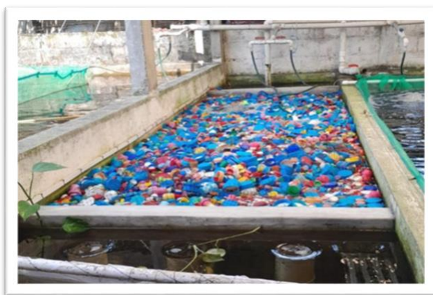
Figura 7. Filtro implementado de tapas plásticas.
