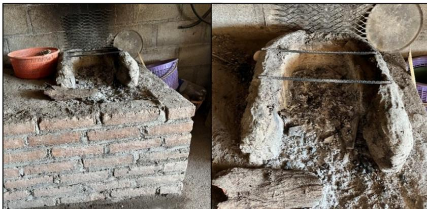
Fig. 4.9 — Fogón tradicional en forma de herradura en la vivienda evaluada.
