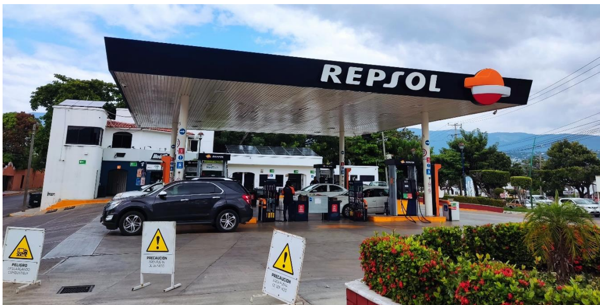
Ilustración 15 Gasolinera “La Diana” Tomada de: Fuente propia
