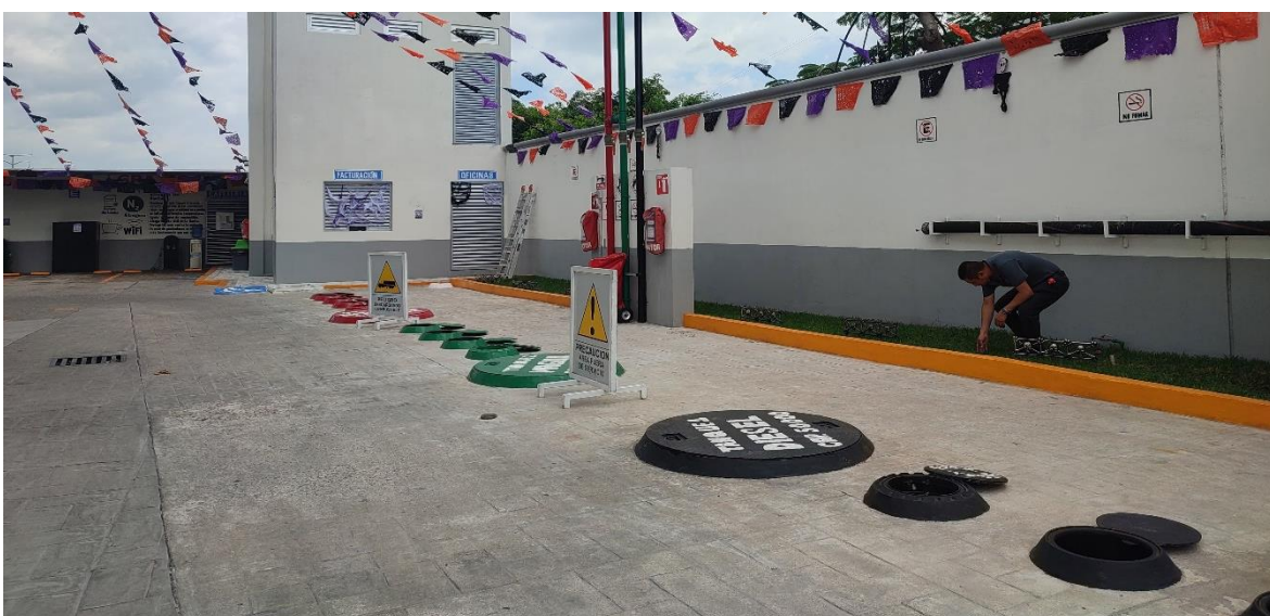
Ilustración 14 Tanques de almacenamiento de la gasolinera "Vialva El Paraíso" Tomada de: Fuente propia
