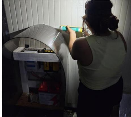
Figura 37. Sellado del domo de los componentes.
