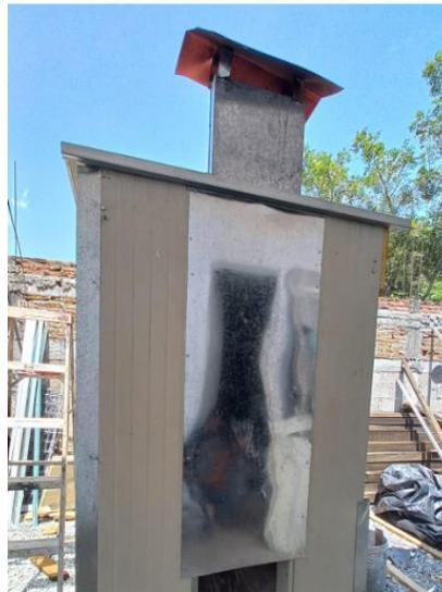
**FIGURA 24. LÁMINA DE AISLAMIENTO TÉRMICO DE LA CHIMENEA**
