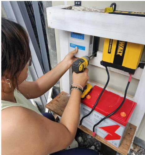
FIGURA 36. CONEXIÓN DE CONTROLADOR.
