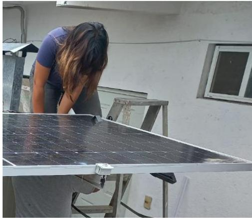
**FIGURA 33 Anclaje de los módulos a la estructura.**
