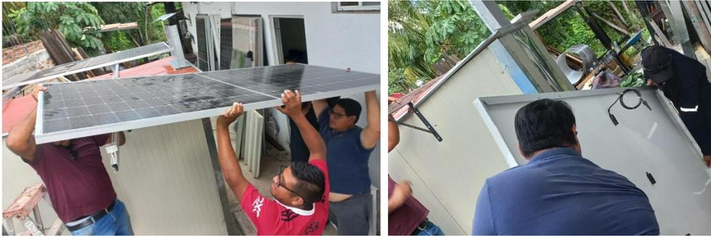
Figuras 31 y 32. Instalación de los módulos fotovoltaico.
