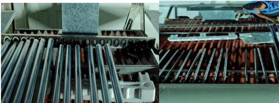
**Figuras 41 y 42. Instalación de los tubos al vacío.**
