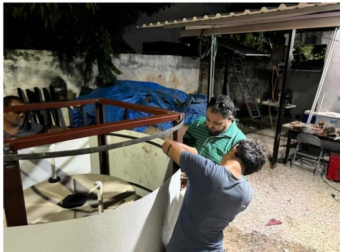
Ilustración 69. Ajuste del recubrimiento a la estructura.
