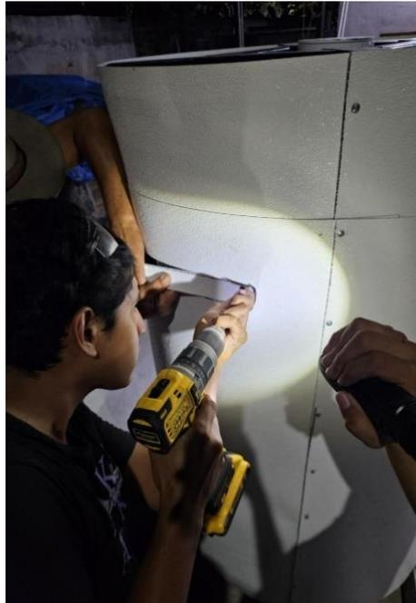
Ilustración 72. Perforación en el recubrimiento para darle paso al sistema de remoción.
