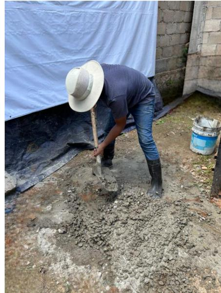
Ilustración 51. Proceso de mezcla de concreto.
