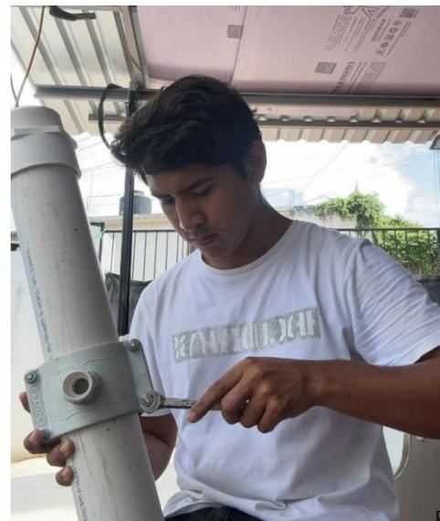
Ilustración 23. Armado de abrazadera en la tubería.
