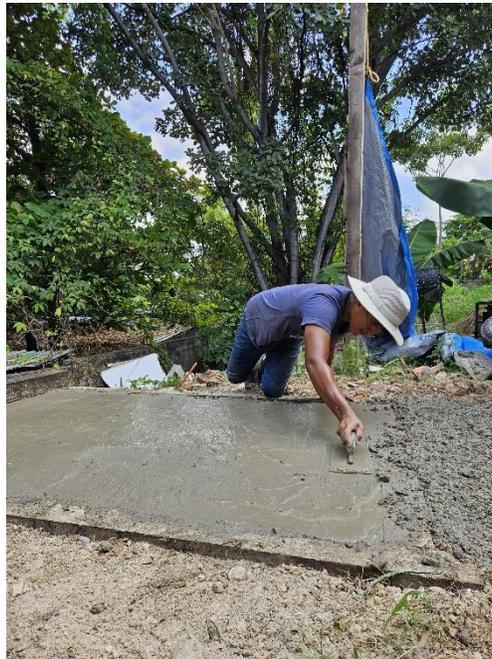
Ilustración 77. Realización de piso del biodigestor.
