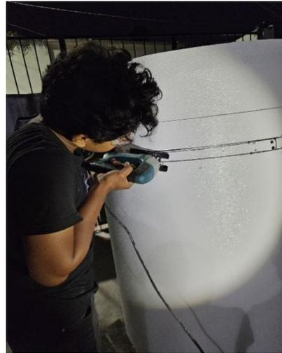
Ilustración 40. Recorte del recubrimiento del lado correspondiente al sistema de remoción.
