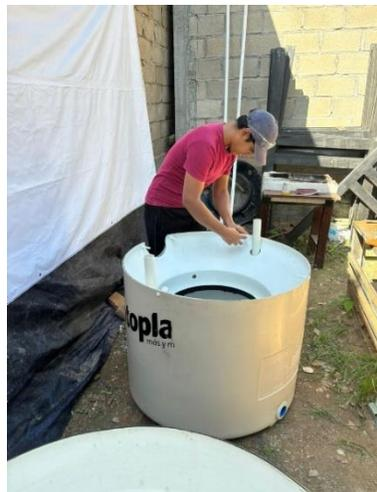
Ilustración 19. Incorporación de bases de sistema de remoción e integración de tornillos de plástico en el contenedor.
