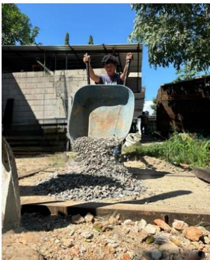
Ilustración 48. Llenado del área asignada del biodigestor con grava.
