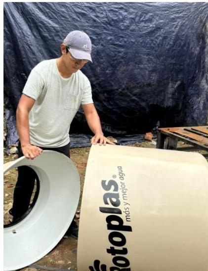
Ilustración 10. Recorte de la parte superior del contenedor.
