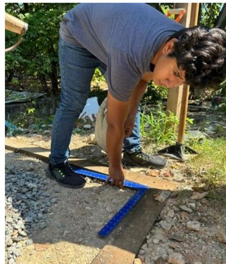
Ilustración 49. Verificación de la correcta posición de los polines de madera.
