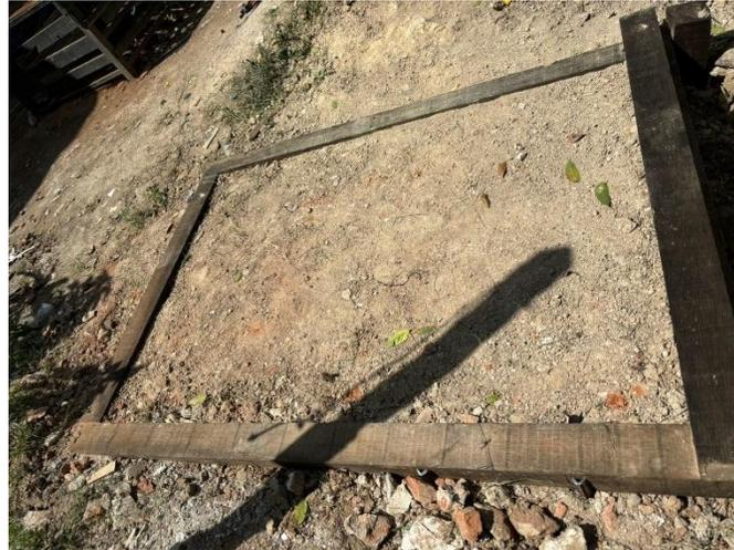
Ilustración 47. Base para el concreto.
