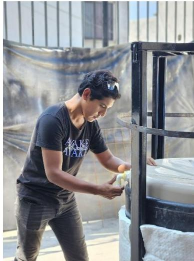
Ilustración 34. Colocación de tubería por donde saldría el biogás.
