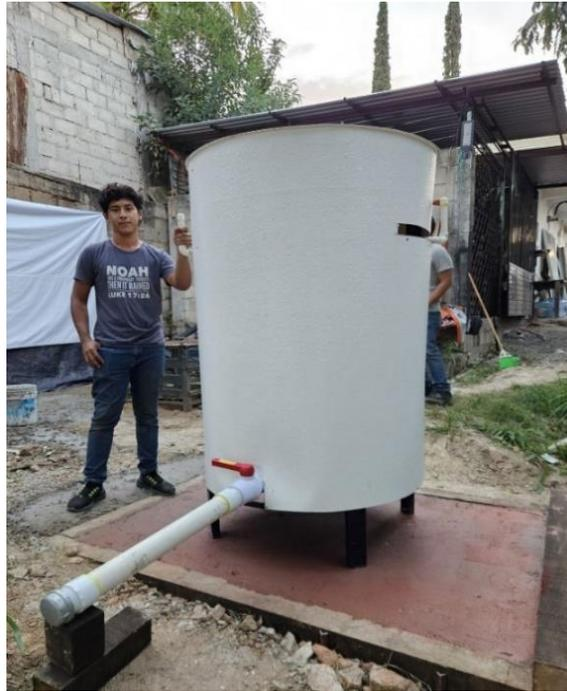
Ilustración 56. Etapa final de la construcción del biodigestor.
