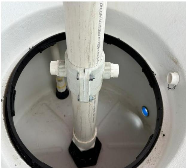
Ilustración 22. Tubería que permite la introducción de materia orgánica en el biodigestor con su abrazadera correspondiente.
