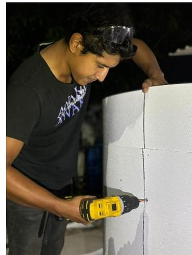
Ilustración 38. Fijación del recubrimiento a la estructura de metal.
