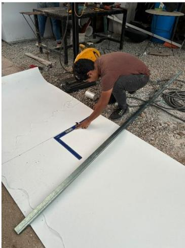
Ilustración 36. Medición del recubrimiento.
