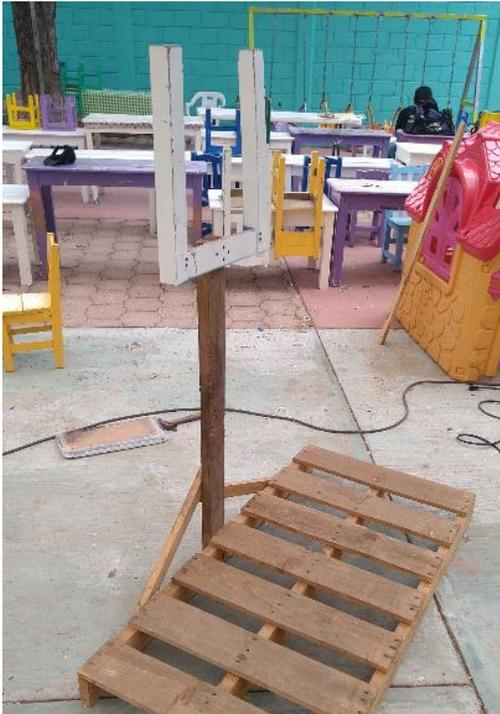
Con los materiales que ya se tenía, reutilizando algunas sillas de madera que se han quebrado por el uso, una palet, reglas clavos y pijas para madera, se creó esta base, para poder montar las alas como se planificó.
