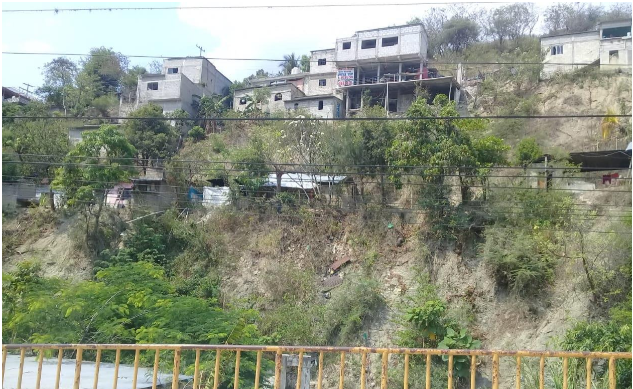
Figura No. 10 Construcción de Viviendas en Zonas de Alta Pendiente (Copainalá, 2021, Coordenadas 477200.14 m E, 1889821.31 m N)
