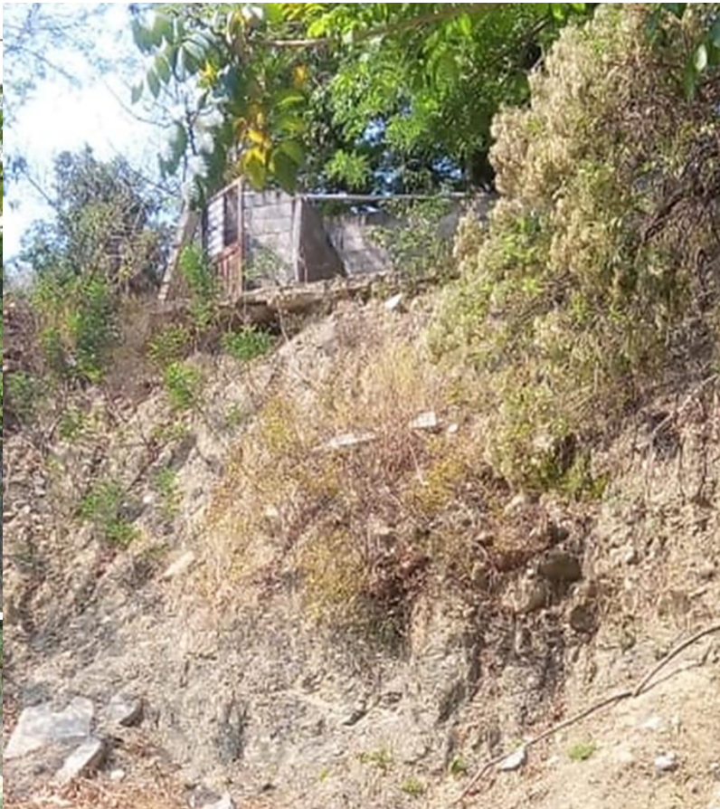
Figura No. 23 Vivienda construida sobre corte de talud, Barrio San Francisco Foto: Trabajo de Campo (2022), Coordenadas geográficas (17° 5'37.08"N, 93°12'52.30"O). Figura No. 24 Daño de vivienda total, Barrio San Francisco, Foto: Trabajo de Campo (2022), Coordenadas geográficas (17° 5'37.08"N, 93°12'52.30"O).
