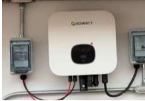
Figura 56 Inversor central.
