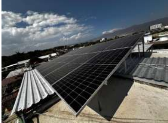
Figura 55 Instalación de los paneles solares.
