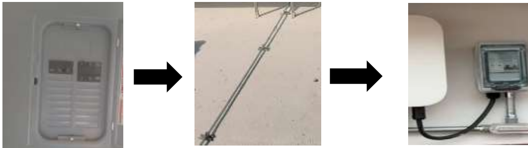
Figura 57 Conexión a la red eléctrica.
