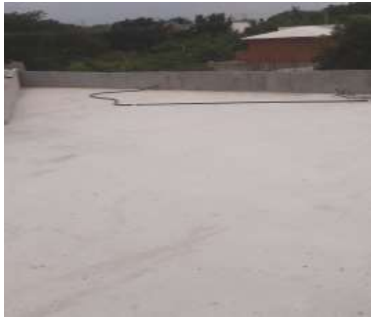
Figura 51 Preparación del sitio.
