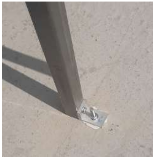
Figura 52 Instalación de soportes.
