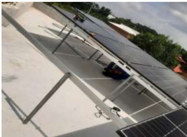
Figura 54 Conexión de los paneles.
