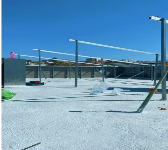
Figura 40. Montaje de la estructura.
