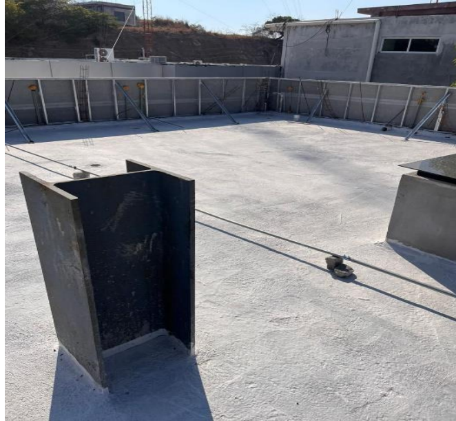
Figura 39. Preparación del sitio.
