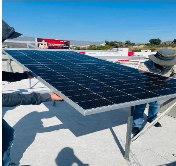
Figura 41. Instalación de los paneles solares.
