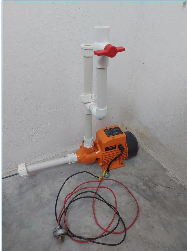
**Ilustración 23** Bomba eléctrica de agua con tubería de C-PVC
