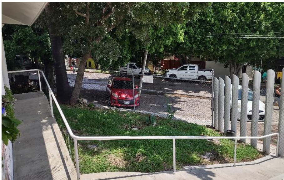
Fotografía 2. Estacionamiento y rampa
