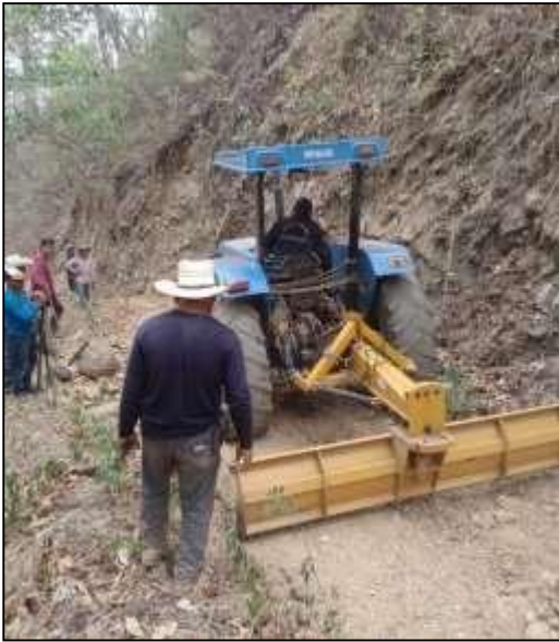
Figura 25 Caminos de difícil acceso
