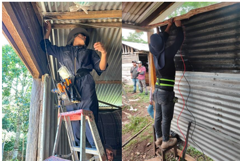
Imagen 55. Cableado de la instalación eléctrica. Imagen por: Mario Benitez.
