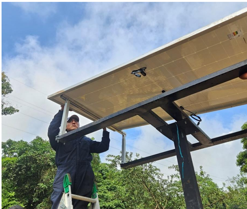
Imagen 41. Montaje del panel fotovoltaico. Imagen por: Darina Ramos.
