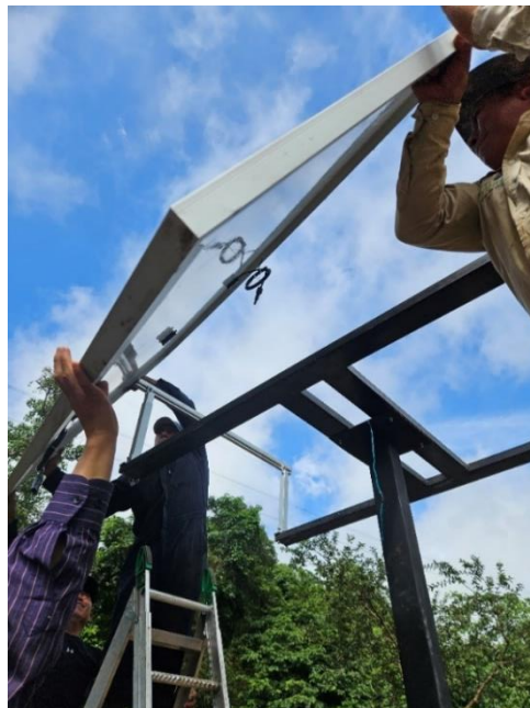
Imagen 40. Ayuda para el montaje del panel fotovoltaico. Imagen por: Darina Ramos.
