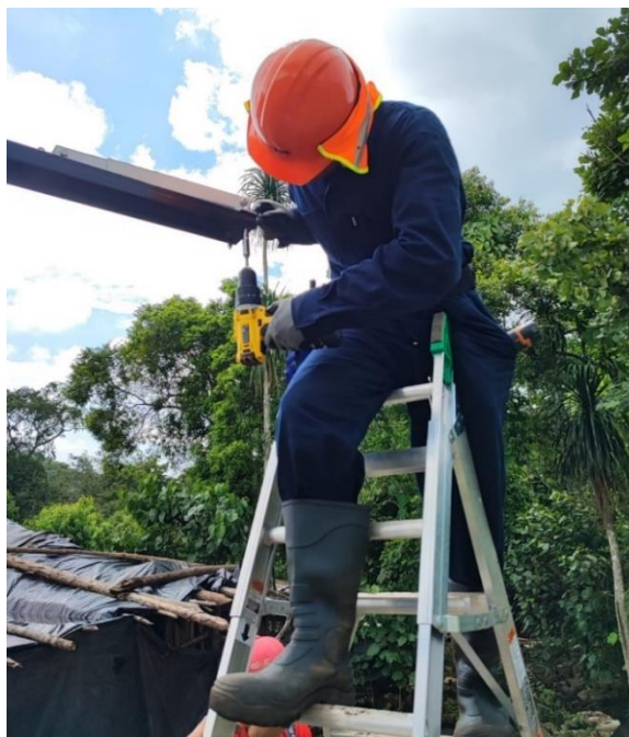
Imagen 37. Fijado de las bases traseras mediante tornillería.
