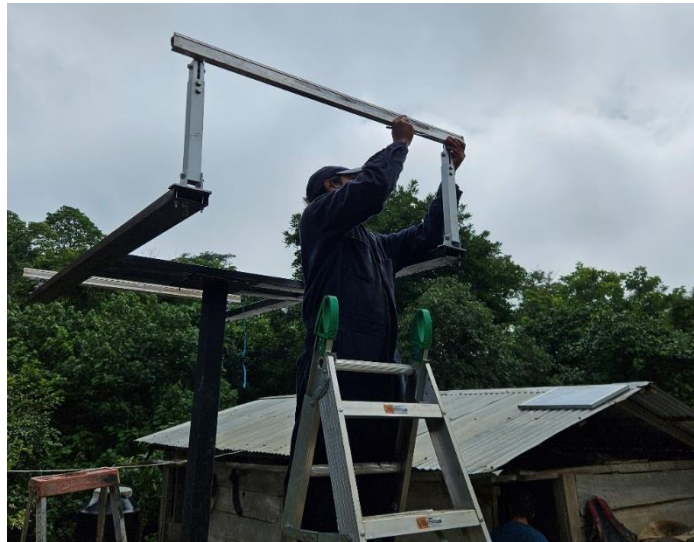
Imagen 39. Fijado de rieles a las bases traseras y delanteras. Imagen por: Darina Ramos.
