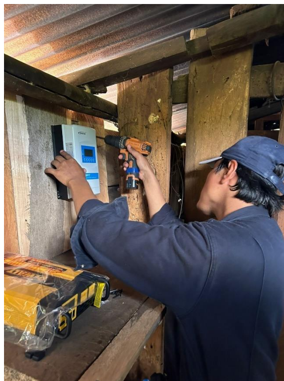
Imagen 44. Fijado del controlador de carga solar a la base. Imagen por: Williams Morgan.
