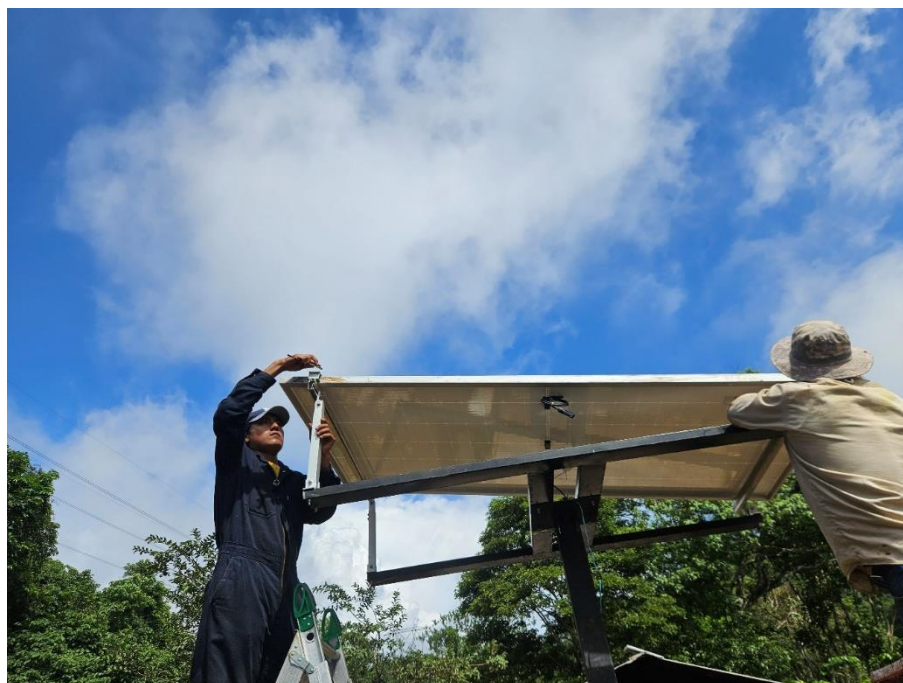
Imagen 42. Sujeción del panel fotovoltaico a los rieles. Imagen por: Darina Ramos.
