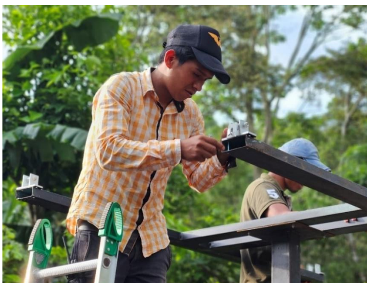
Imagen 38. Fijado de las bases delanteras. Imagen por: Mario Benitez.
