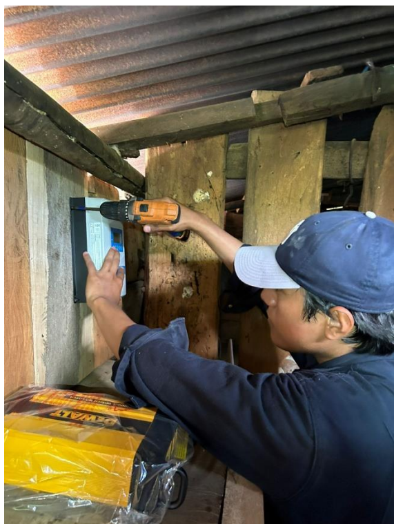
Imagen 43. Fijado del controlador de carga solar a la base. Imagen por: Williams Morgan.
