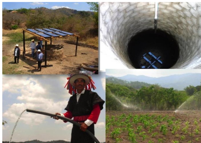
Imagen 3. Bombeo fotovoltaico, el Tuzal.
