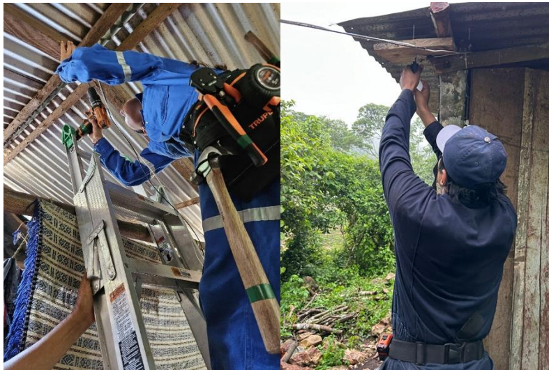
Imagen 58. Instalación de sockets y focos. Imagen por: Mario Benitez.
