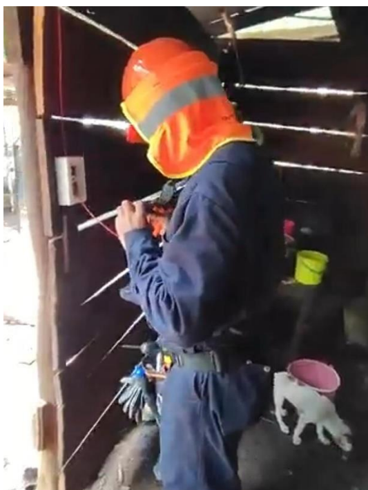
Imagen 56. Instalación de la caja universal y apagadores. Imagen por: Óscar Martínez.
