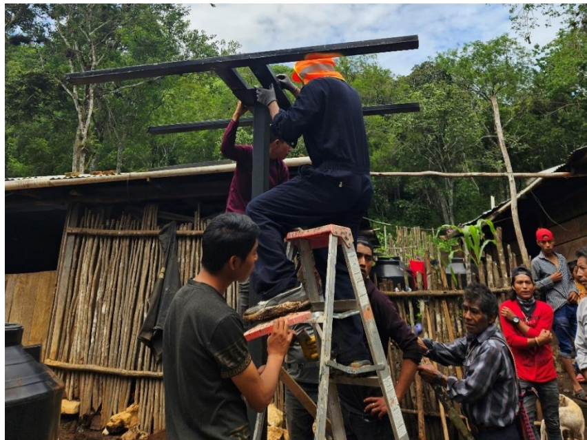
Imagen 36. Fijado de la estructura en forma de H mediante tornillería. Imagen por: Óscar Martínez.
