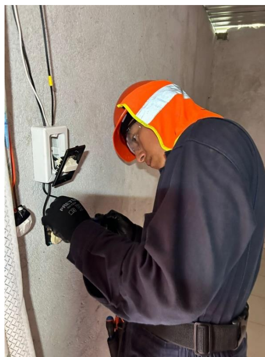
Imagen 57. Instalación del tomacorriente. Imagen por: Óscar Martínez.
