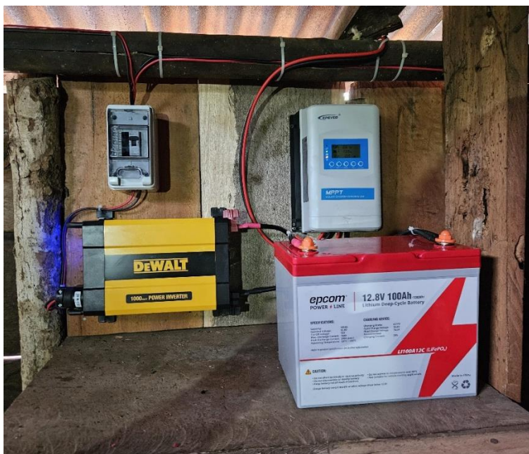
Imagen 48. Componentes del SF autónomo conectados. Imagen por: Williams Morgan.
