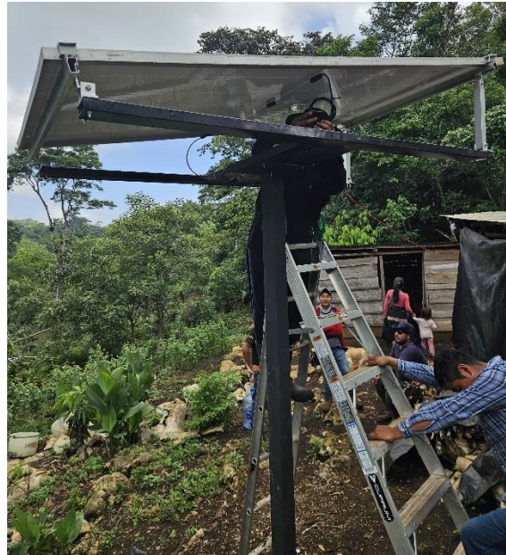
Imagen 49. Conexión del panel fotovoltaico al controlador de carga. Imagen por: Darina Ramos.
