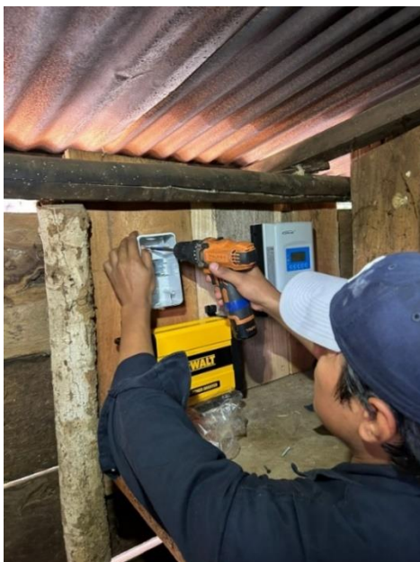
Imagen 54. Fijado del centro de carga a la base. Imagen por: Mario Benitez.
