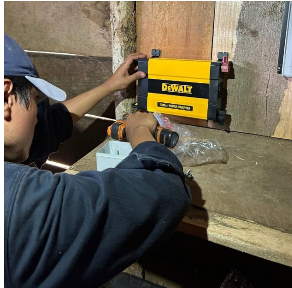
Imagen 45. Fijado del inversor de corriente a la base. Imagen por: Williams Morgan.
