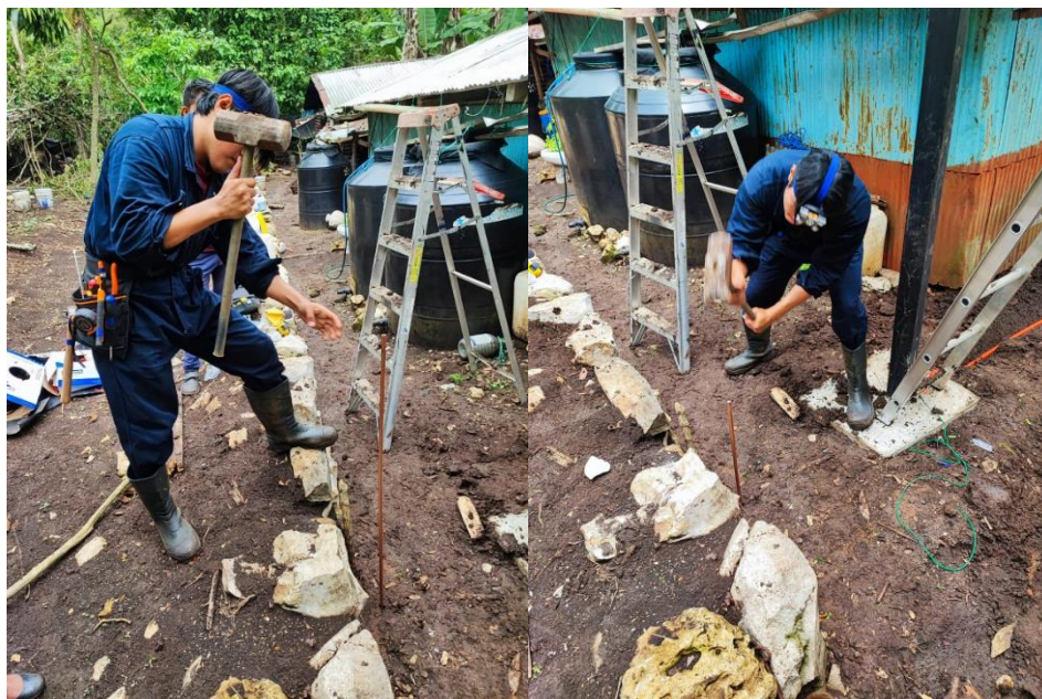
Imagen 50. Instalación de la protección de tierra del SF. Imagen por: Uriel Chalé.
