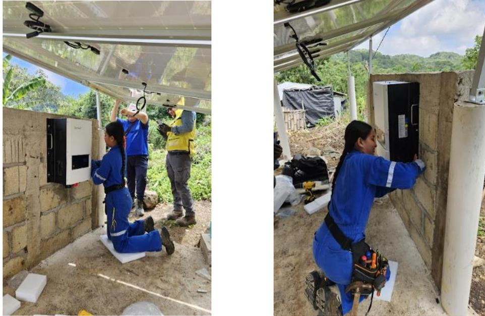
*Figura 24 Instalación del sistema de regulación y conversión.*
