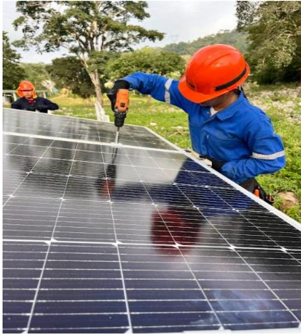
Figura 22 Fijación de los paneles solares
