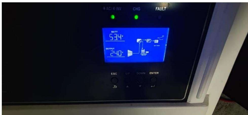
Figura 33 medición de voltaje en banco de baterías.
