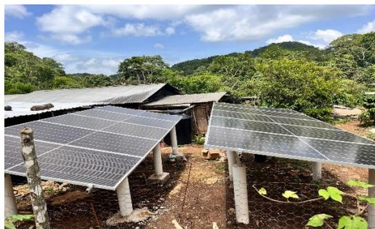
figura 5 sistema fotovoltaico autónomo instalado en una comunidad rural de Chiapas.
