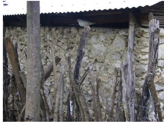
Figura. 9 Casa hecha de piedra y cemento, autor: MR.
