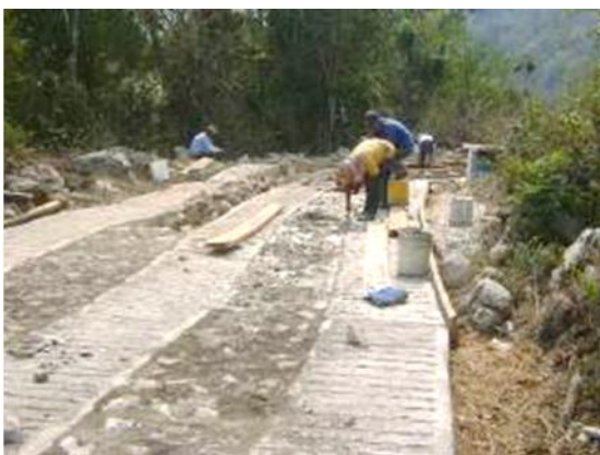
Figura. 31 Elaboración de rodadas para tramos del camino a la comunidad, autor: MR.
