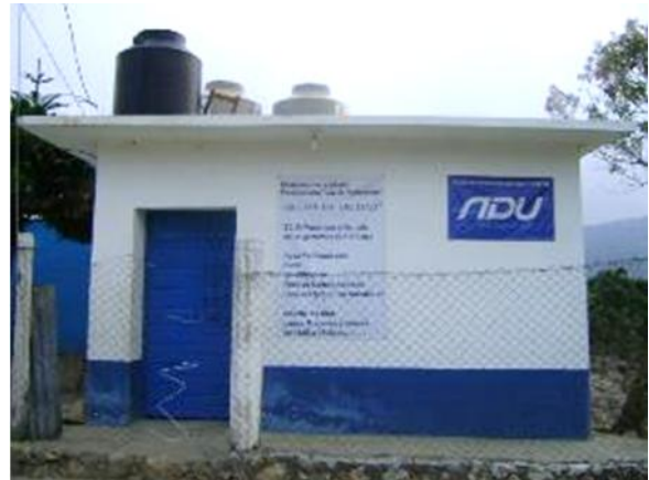
Figura. 59 Planta purificadora de agua, autor: MR.
