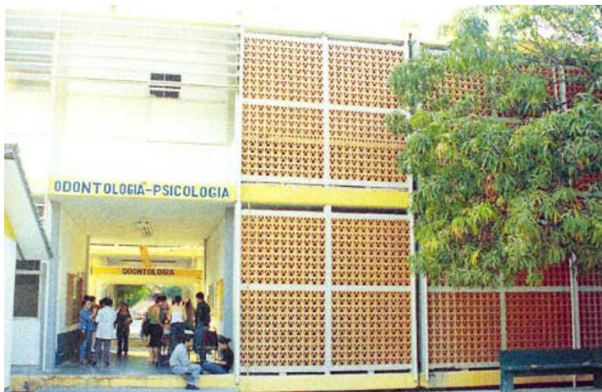
Figura 1. Instalaciones del ICACH
