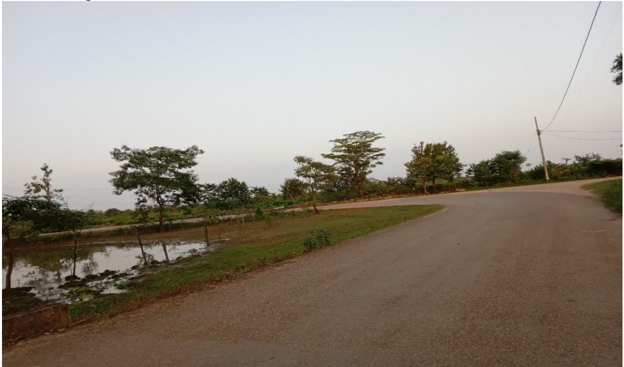
Figura 17. Punto de Riesgo 3
