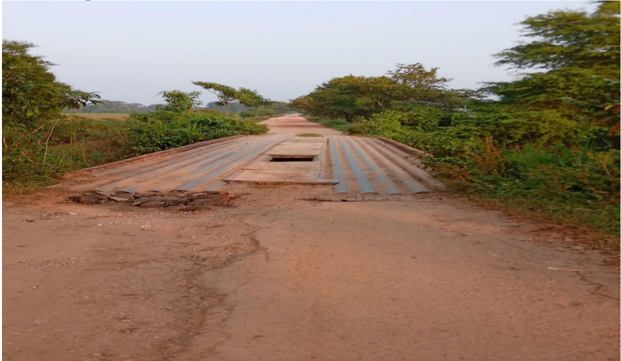
Figura 19. Punto de Riesgo 5
