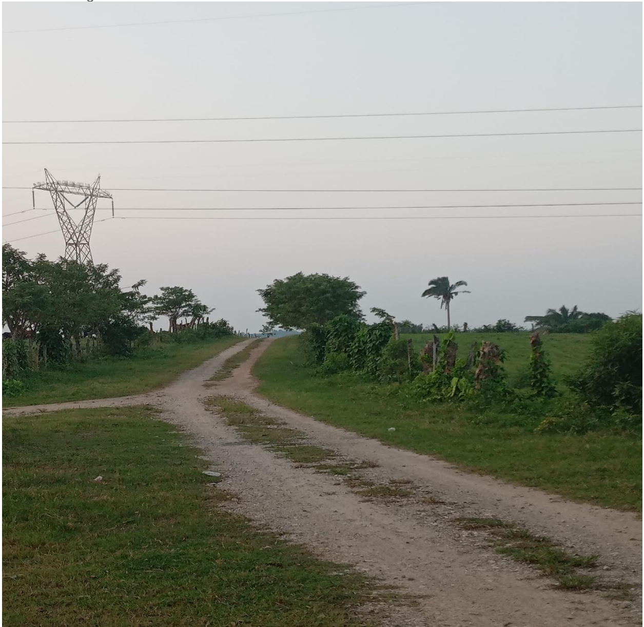
Figura 25. Punto de Riesgo 11
