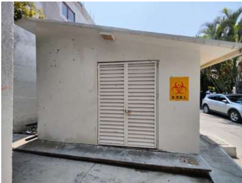
Ilustración 4. Almacén temporal y su señalización. Fuente propia.
