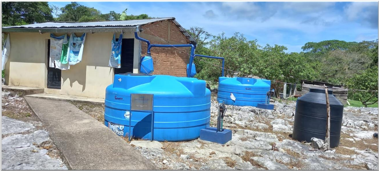
Figura 25. Sistemas de captación de agua de lluvia. Fotografía de Carmela Lázaro. Montebello, Berriozábal, Chiapas. Julio 2023
