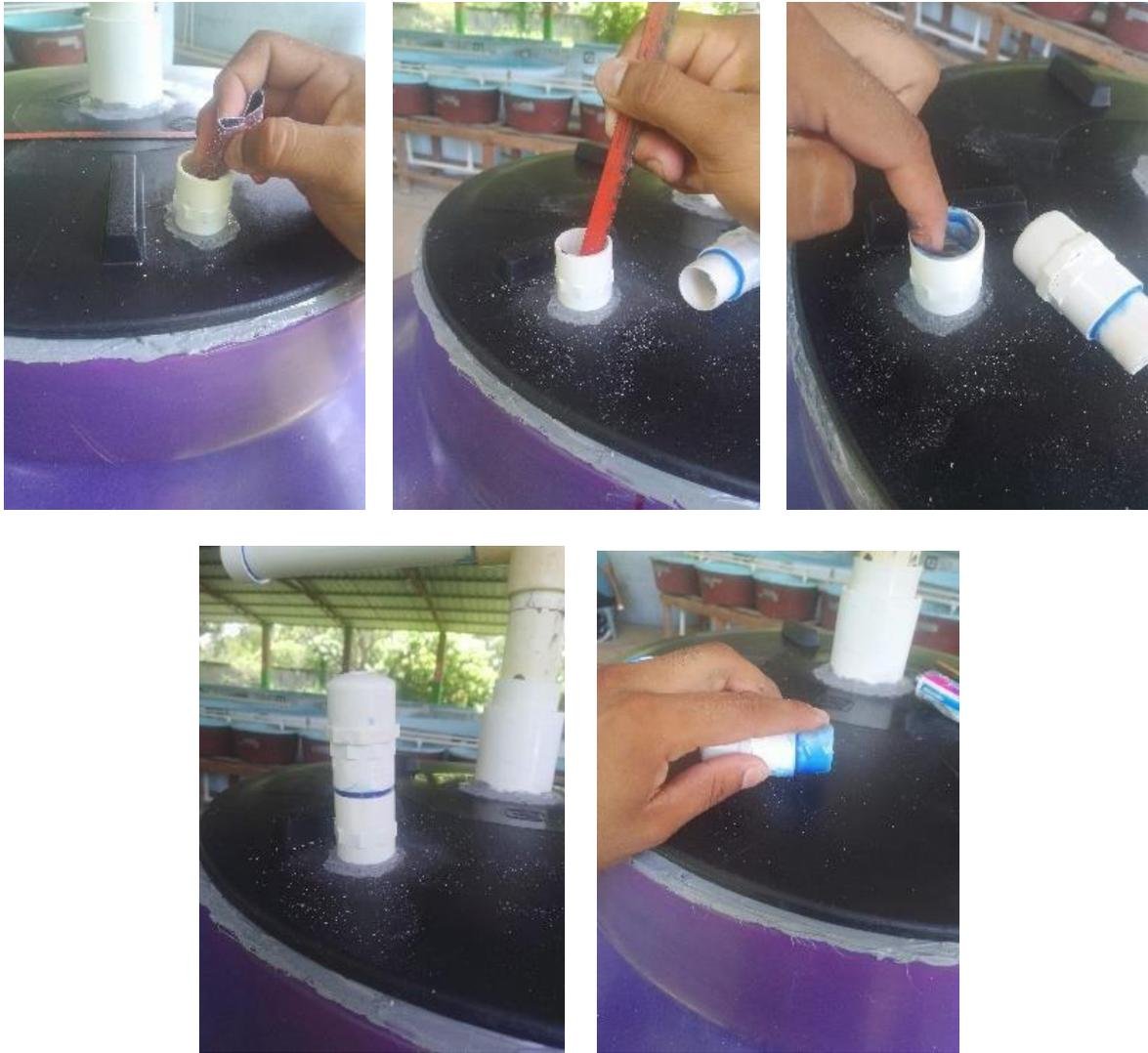
**Figura 23.** Desgaste del cree hembra y empinado del tramo de 3/4" al cree hembra antes instalado.
