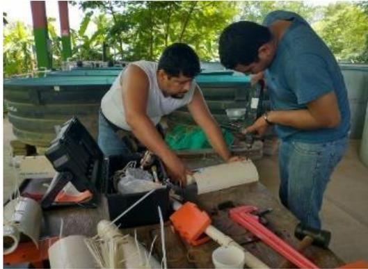
**Figura 41.** Realización de los orificios donde irían los cintos posteriormente.
