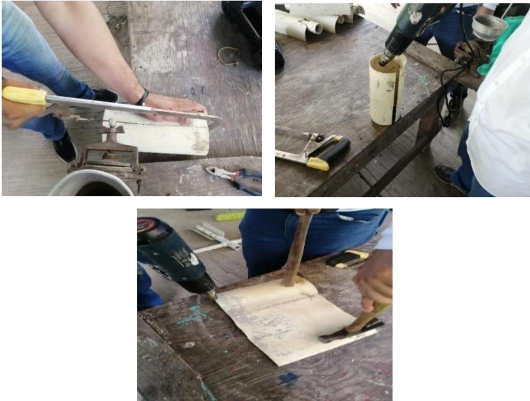
**Figura 31.** Proceso de cortado de tubo de PVC de 6" y posterior ablandado y aplanado de las placas
