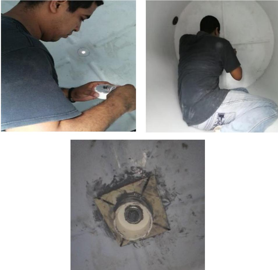
**Figura 36.** Aplicación del sellador al tapón que posteriormente iría unido a la placa de 16 x 16 cm, instalación del tapón ya ensamblado al tornillo y placa visto desde el interior del contenedor.
