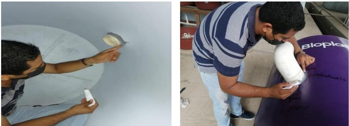
**Figura 13.** Pegado de la rosca de seguridad de PVC y el cree macho de PVC.
