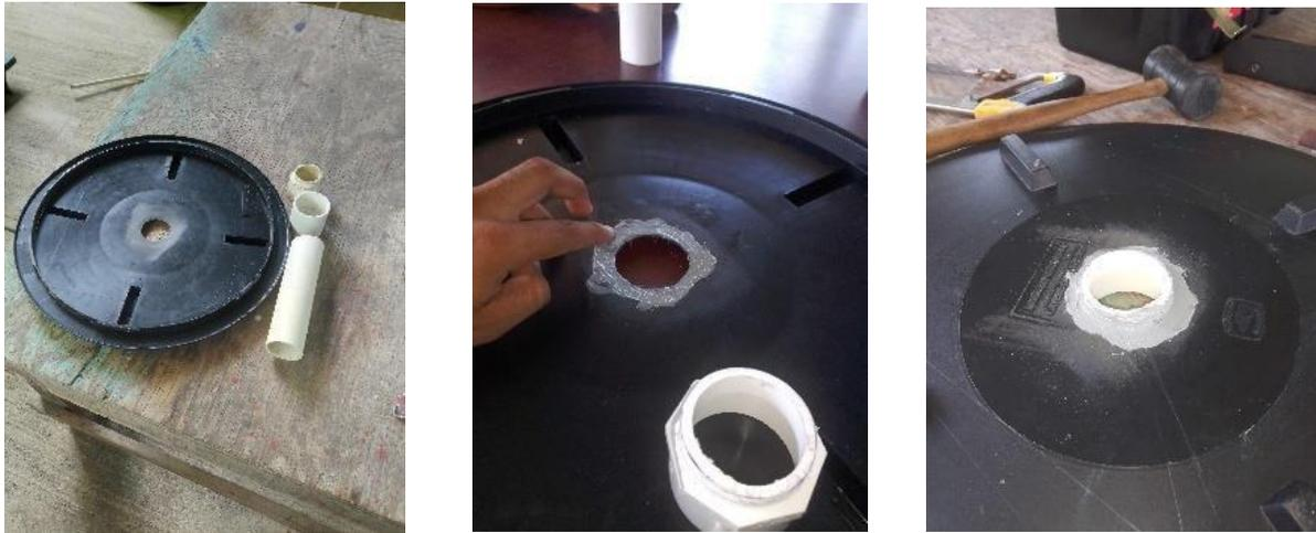
**Figura 28.** Materiales y ensamblado del cree macho a la tapa
