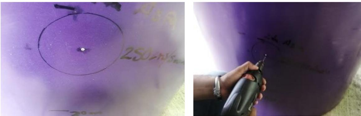
**Figura 11.** Calcado e inicio de la perforación del influente con brocas finas.
