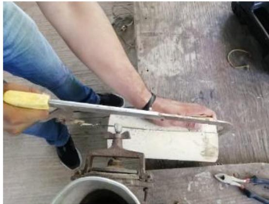
**Figura 38.** Cortado de los tubos de 6", para la realización de las aspas.
