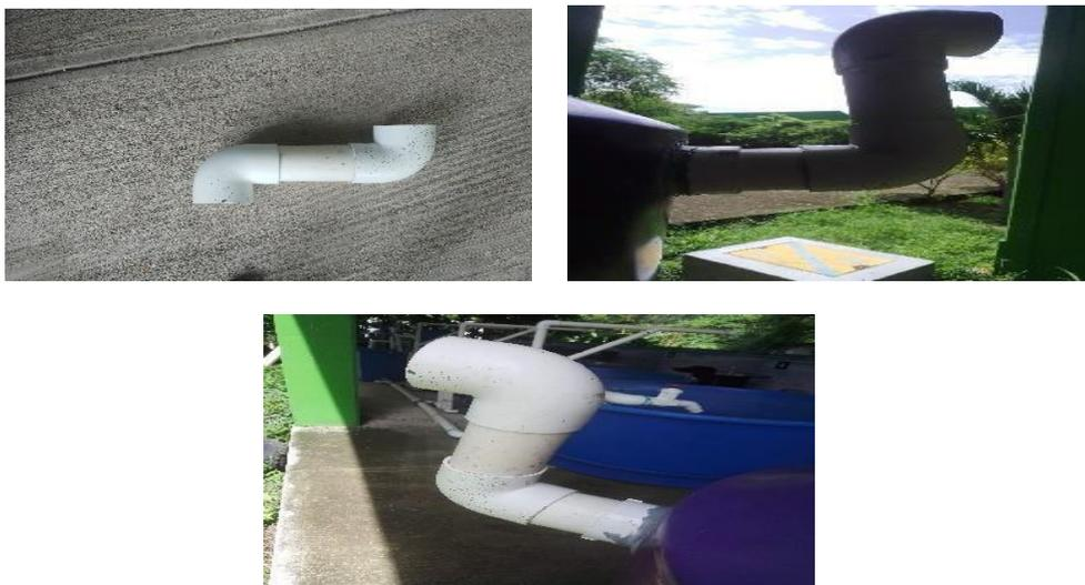
**Figura 17.** Ensamble de la estructura del efluente
