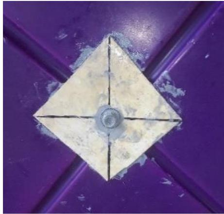
**Figura 37.** Añadido de la segunda placa al tornillo sobresaliente desde la parte interior del tinaco, y posterior anexión de la tuerca de presión y sellador gray.
