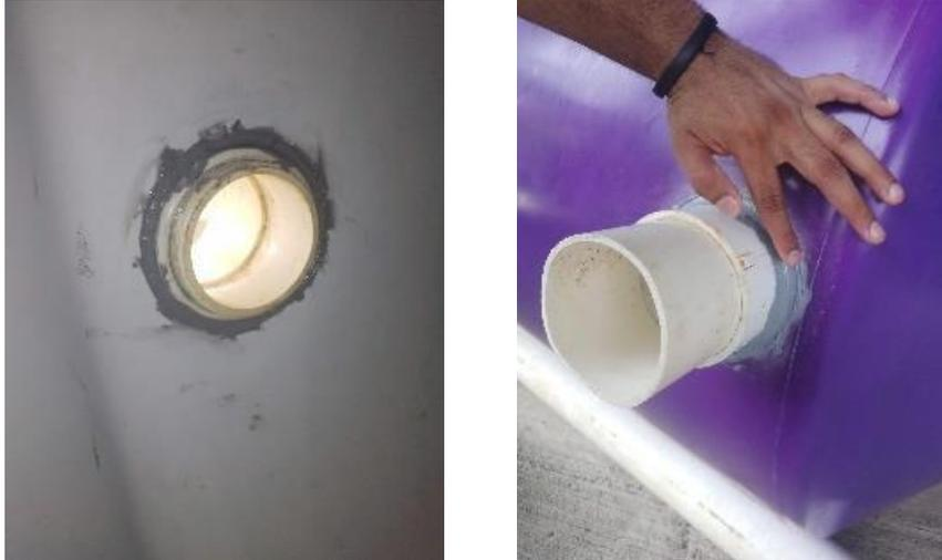
**Figura 16.** Ensamble de la rosca interna de seguridad, el cree macho y el tramo de PVC.
