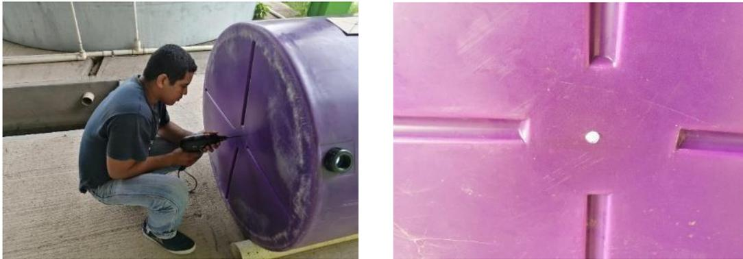
**Figura 30.** Detalle de la ejecución de la perforación F)
