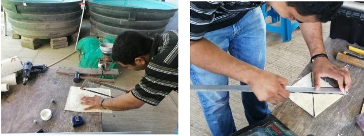
**Figura 32.** Cortado de las placas y trazado y obtención del punto central en donde irían los orificios
