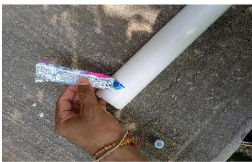
**Figura 57.** Lijado y aplicado de pegamento del tubo de PVC
