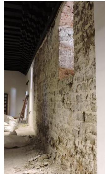
**Figura 22. A la izquierda, uno de los muros de la planta baja del convento realizados con adobes. Los cimacios fueron realizados con piedra. A la derecha muro con ventanal con refuerzo en el arco de ladrillos. La imagen fue tomada durante los trabajos de reposición de los aplanados de cal y arena dañados por el sismo de 2017. Fotos: Haydeé Orea**
