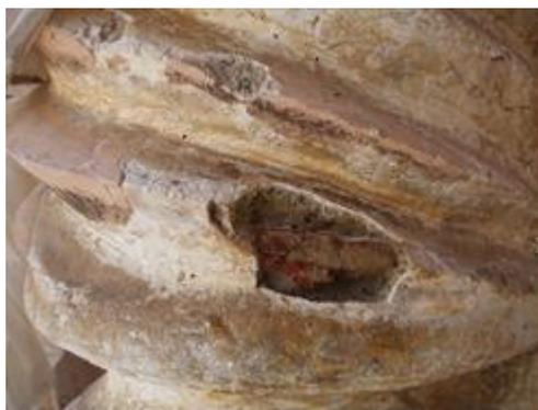
**Fig. 65. Cala realizada en un resane de una columna del tercer cuerpo.**
