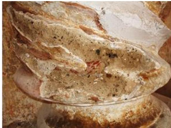
**Fig. 69. Detalle argamasa columnas. Foto: Constantino Armendáriz**
