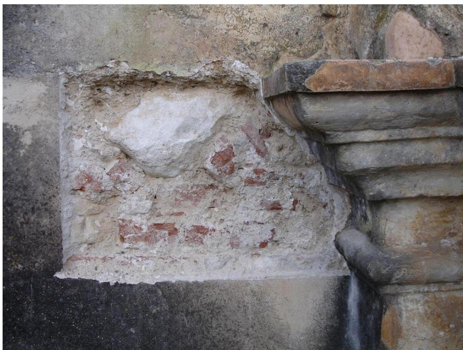
**Figura 27. Cala realizada durante los trabajos de conservación en uno de los muros que soportan la fachada y que evidencia los materiales empleados: ladrillo y piedra, rejunteados con morteros de cal y arena, y la ausencia de un aplanado pintado sobre el soporte. Mayo del 2006.**
