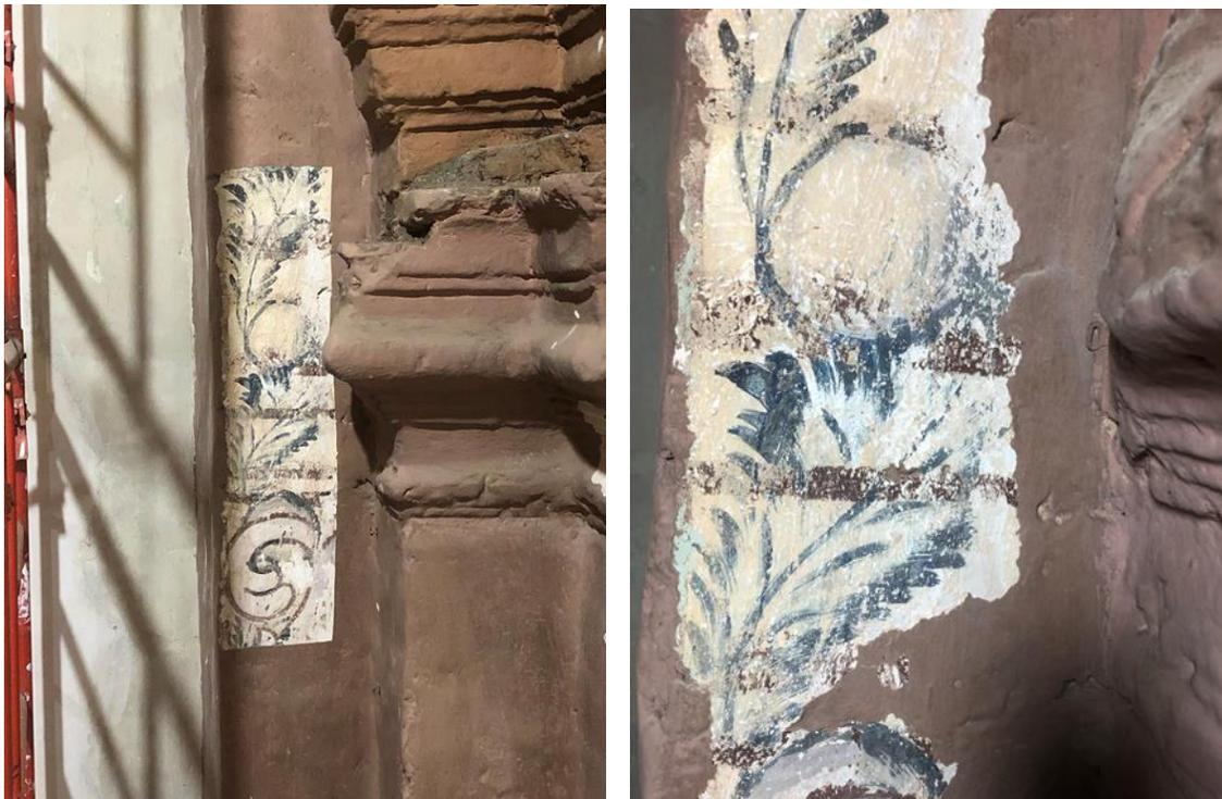
**Figuras 41 y 42. Cala realizada en una moldura del muro testero que muestra unos pocos restos de dicha pintura mural durante el proyecto de conservación del templo en el 2021. Foto: Haydeé Orea**
