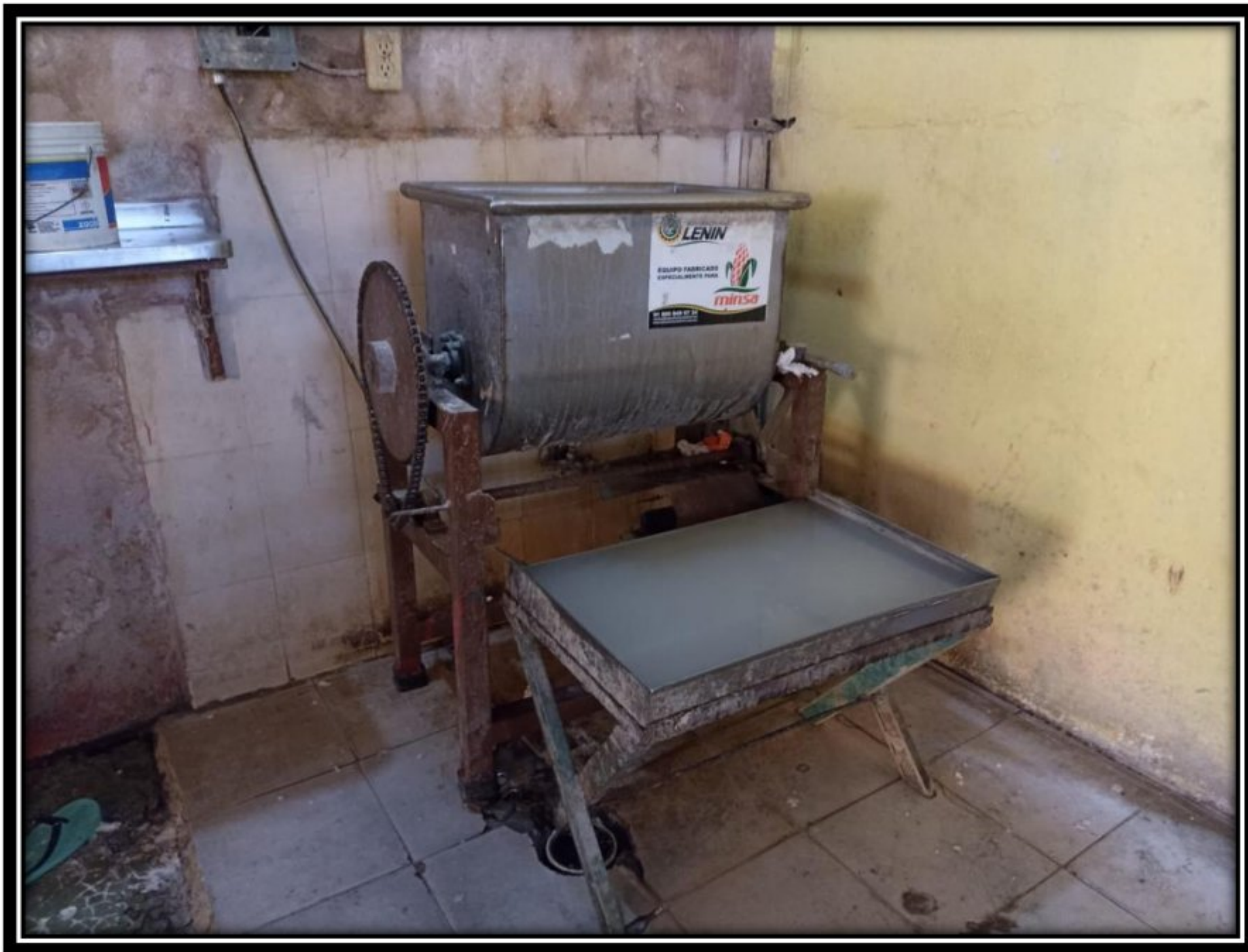
Ilustración 15 Riesgo eléctrico. Fuente: Con base a la información obtenida
