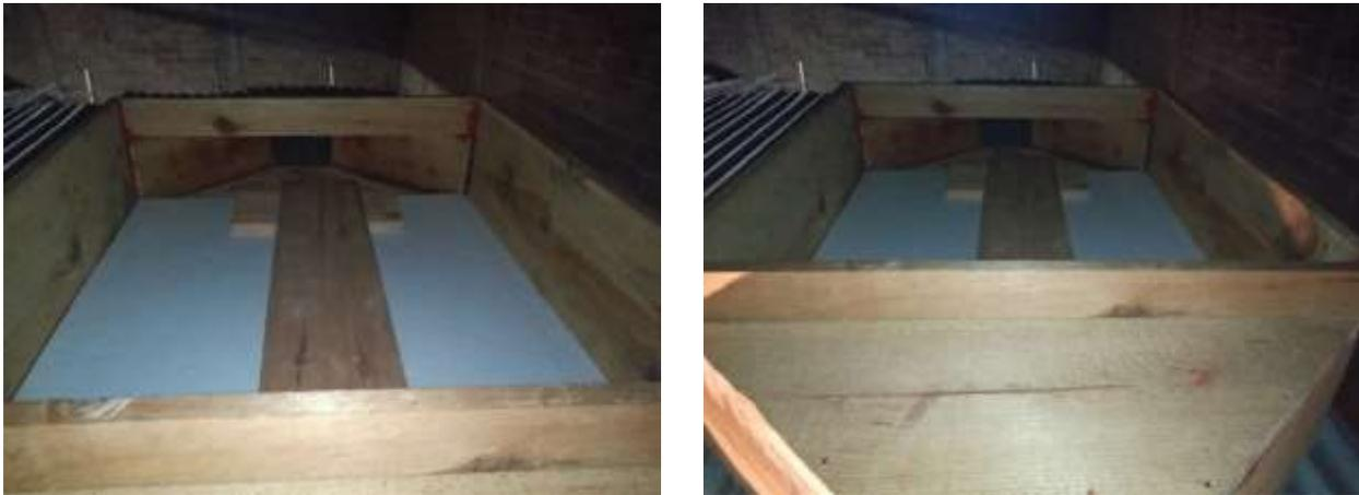
*Figura 10 Colector con placa aislante*
