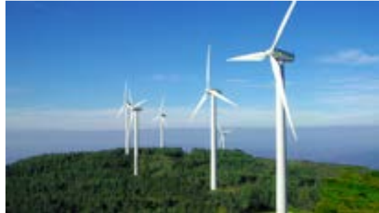
Figura 3.7. Aerogenerador de eje horizontal. Fuente: [45].
