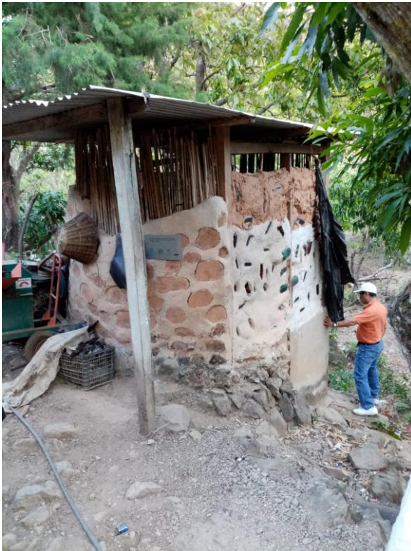
Figura 10. Primer baño seco construido, localizado en El Vergel, Pijijapan, Chiapas; de donde se tomó la muestra P6.
