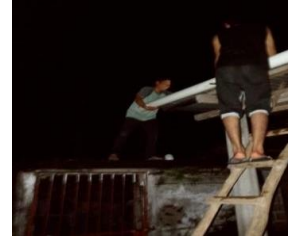
Imagen 4, instalación del tubo PVC, en el techo
