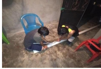
Imagen 3, corte del tubo PVC, para hacerle canal y captar agua.
