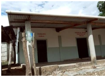
Imagen 5, se colocó el cuerpo de filtro.
