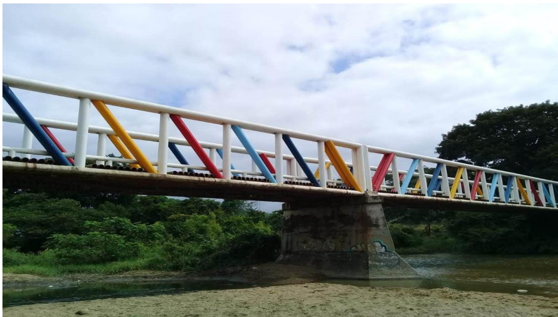
Figura 7. Puente que conecta a la comunidad.
