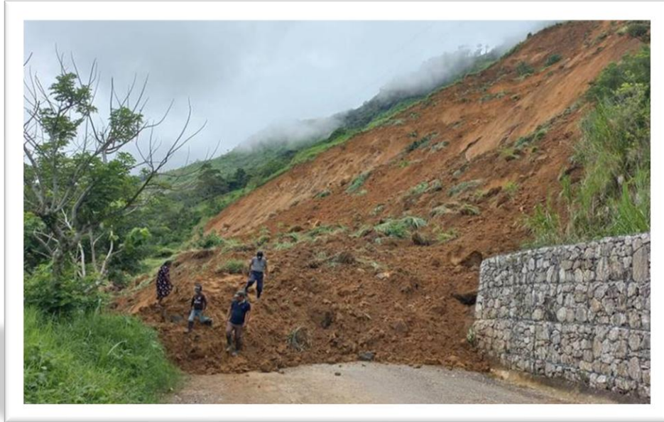
Figura 15. Deslizamientos de Laderas en el municipio de Amatán. Fuente: López (2022).
