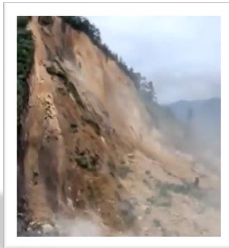
Figura 13. Deslizamiento de tierra en el municipio de Chamula. Fuente: GH ((2022).
