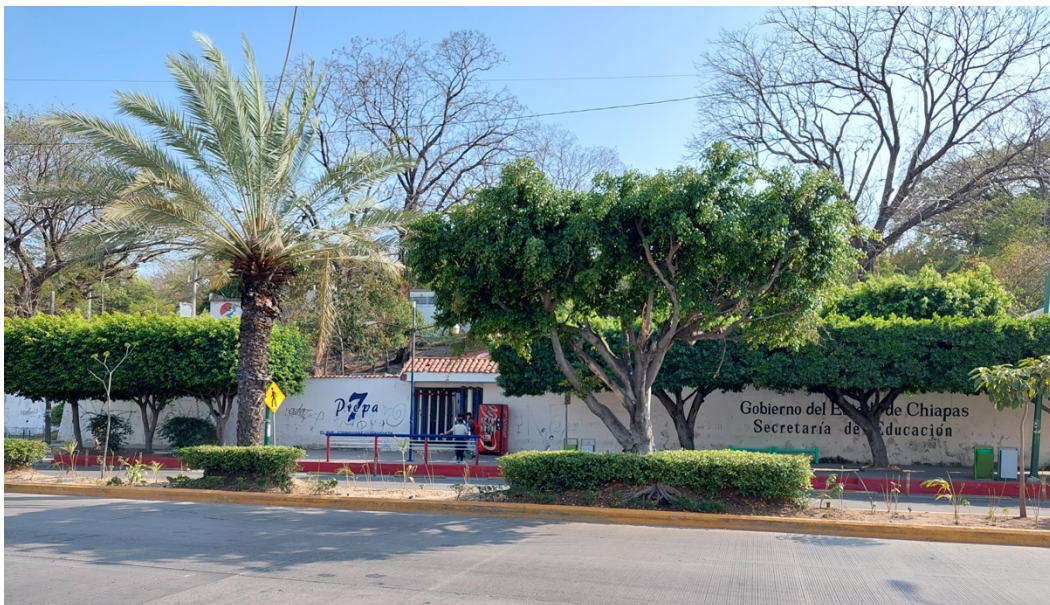
Figura 2. Escuela Preparatoria No. 7 del Estado en Tuxtla Gutiérrez, Chiapas.
