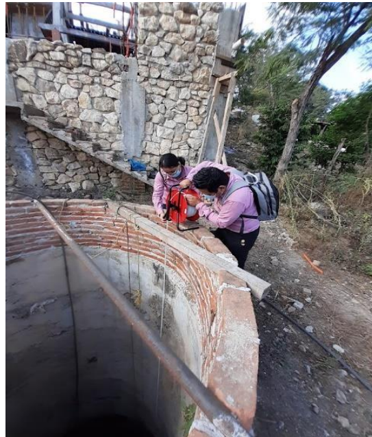
Fotografía 8: Obtención del Nivel Piezométrico con la sonda de medición Sonlist (Hernández, M. 2021)
