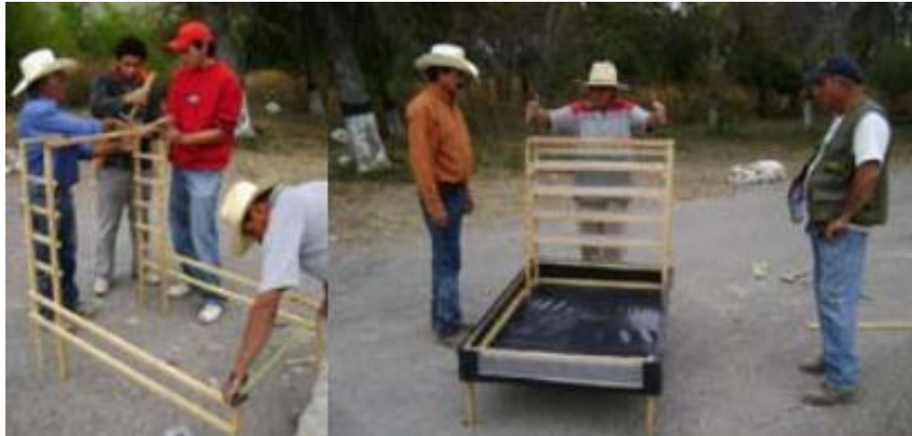
Figura 4. Construcción de un deshidratador.
