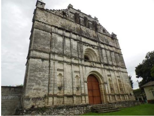
Figura 49. Fachada del templo de la virgen de la Asunción, en Soyatitán, (Cruz, 2022).
