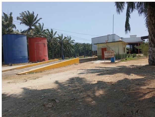
Tanques de almacenamiento del aceite crudo de palma y Báscula.
