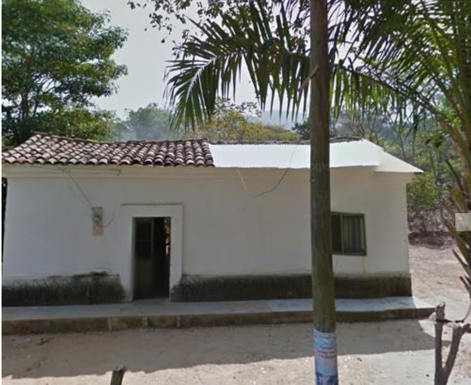
Figura 2. Vivienda de la colonia
