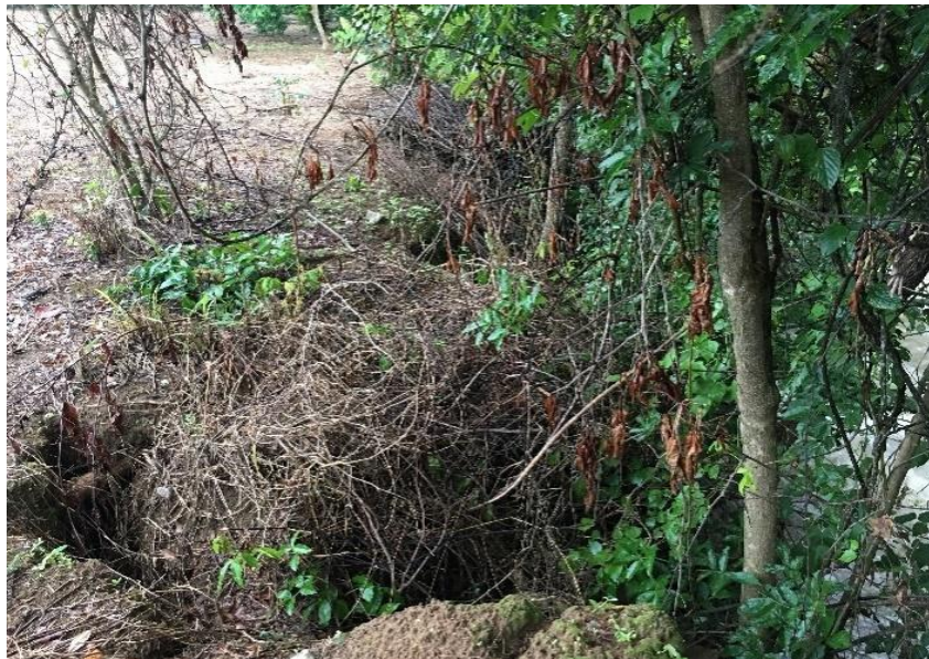
Figura 2 zona identifica por degradación del suelo.
