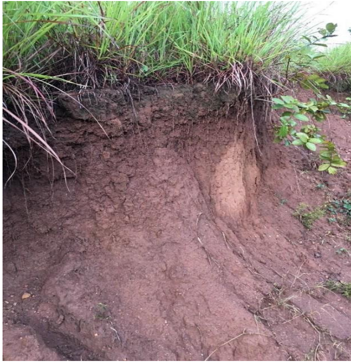
Imagen. - 14 En esta zona de identifico con la mayor degradación que existe en la zona con 28 metros 15N31237.04 1754145.76.
