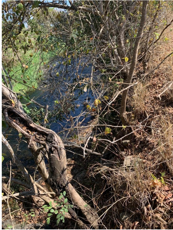
Figura 3 Zona dañada por el río limón.
