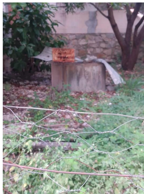
Figura 21. Pozo entubado a la vertiente. Archivo propio
