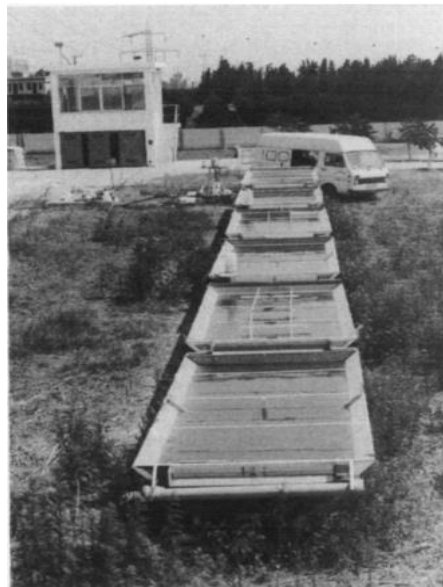
Figura 11. Vista general de la planta piloto. Fuente: (A. Acher et. al. 1990)
