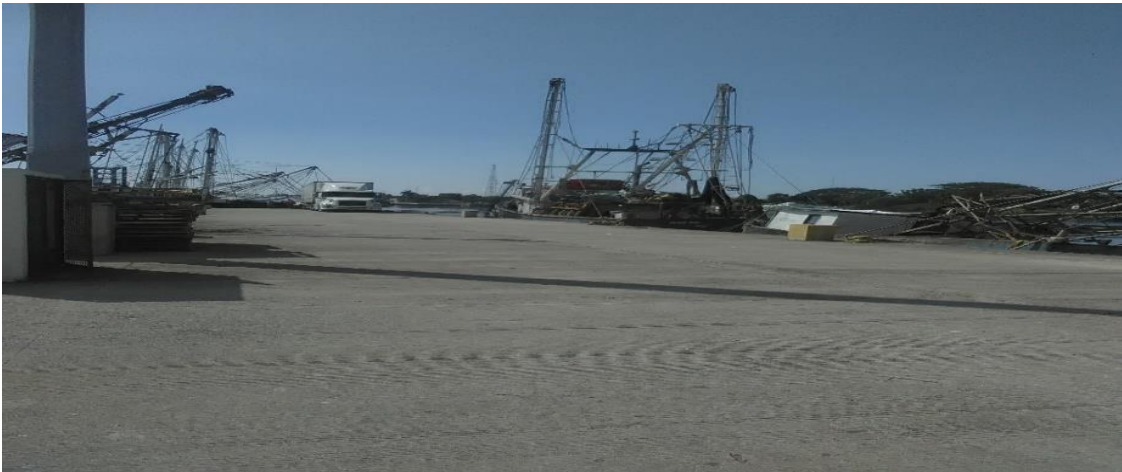
Figura 26.- Vista interna del muelle II de la agencia portuaria de Puerto Chiapas
