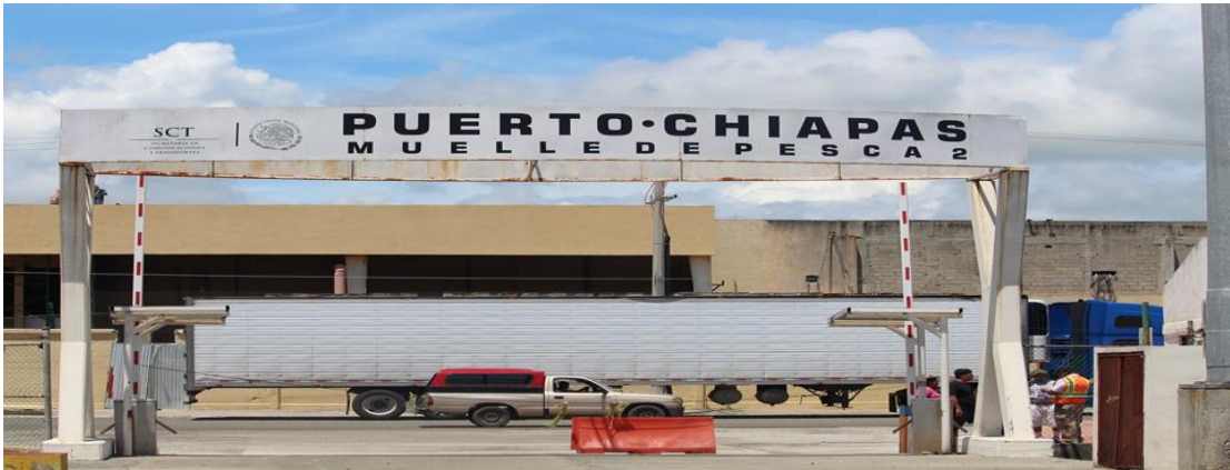
Figura 25.- Fachada del muelle II de la agencia portuaria de Puerto Chiapas
