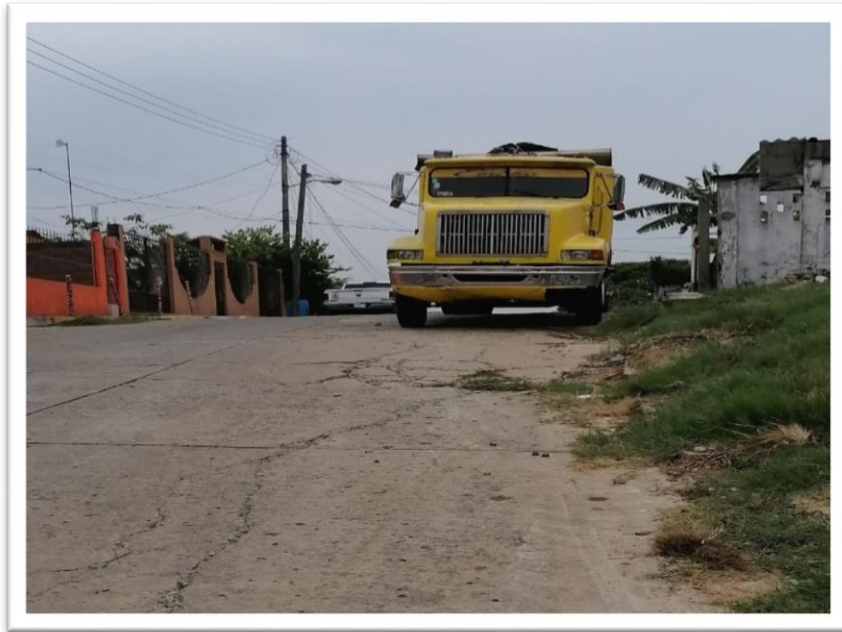
Figura 20. Transporte con carga pesada deteriorando las calles
