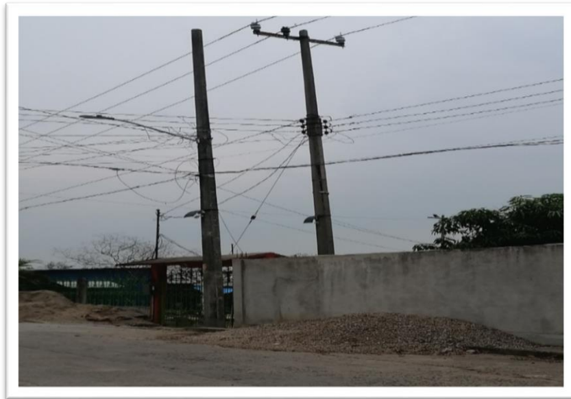
Figura 21. Material de construcción tapando el paso peatonal
