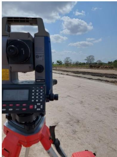
Figura 17 : Replanteo de puntos en hombros de casetas para iniciar con la nivelación
