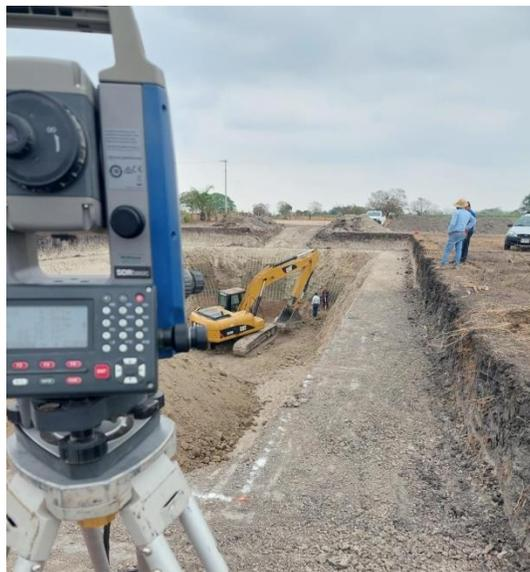
Figura 15 Trazo de puntos para controlar el corte de la cisterna
