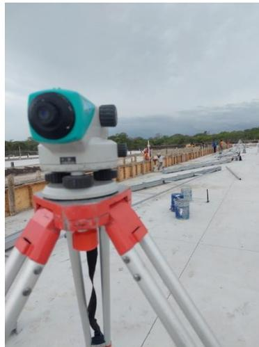
Figura 21 Nivelado de placas para estructura de techo y laminación.
