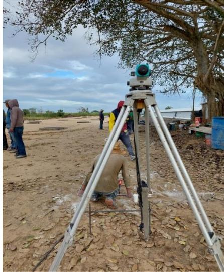
Figura 20 Trazo de columnas para muros.
