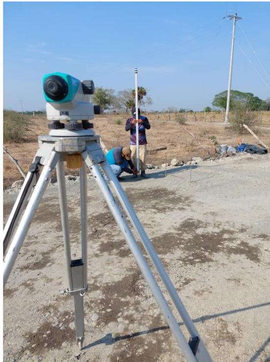
**Figura 19 paso de nivel en crucetas de trazo.**
