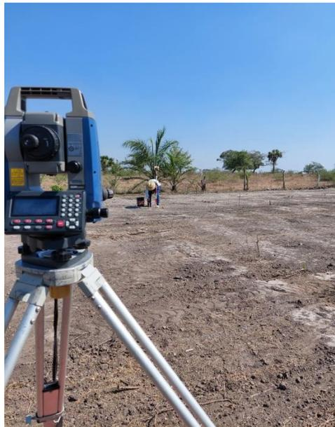
Figura 13 Replanteo y trazo de puntos de la cisterna
