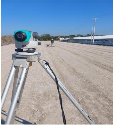
**Figura 18 Nivelado de trompos con cotas para afinar con la motoconformadora**
