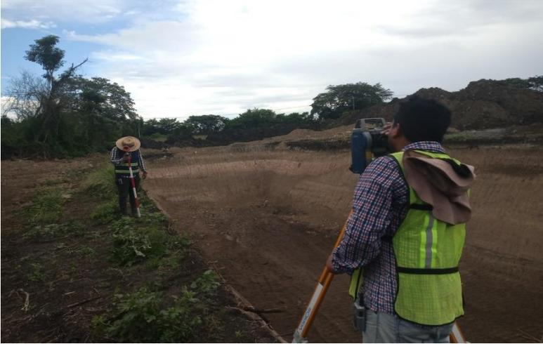
Figura 14 Levantamiento topográfico del corte de la cisterna
