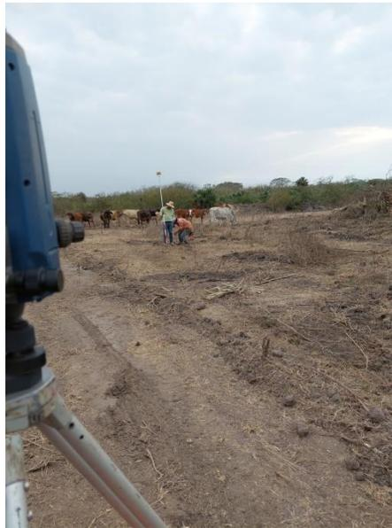
**Figura 11 Replanteo y trazo de puntos de plataformas**
