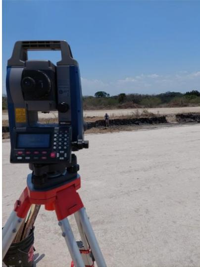
Figura 16 Trazo y replanteo de puntos en vialidad interna
