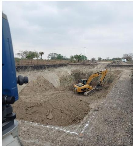
Figura 25 Replanteo y trazo de puntos para control de corte en cisterna
