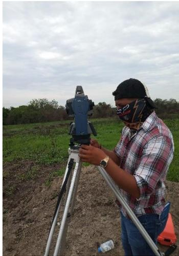
**Figura 23 Nivelado para orientación de equipo**
