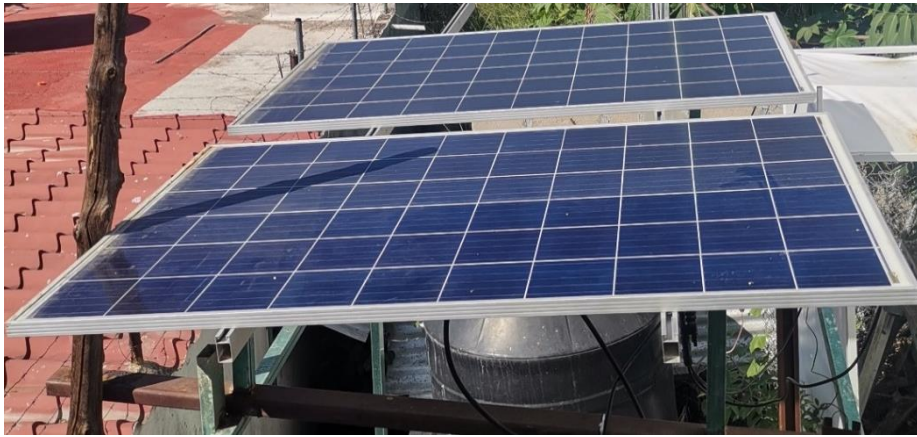
Ilustración 49. Sistema fotovoltaico interconectado a red con una sombra simulando un tubo sobre uno de los módulos del sistema.
