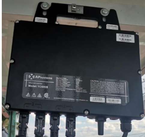
Ilustración 9. Microinversor APsystems YC600B.
