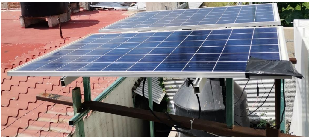
Ilustración 45. Sistema fotovoltaico interconectado a red con una sombra en una celda de uno de los módulos del sistema.
