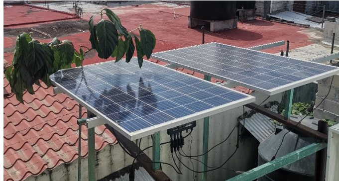
Ilustración 52. Sistema fotovoltaico interconectado a red con la sombra de una rama de un árbol sobre uno de los módulos del sistema.
