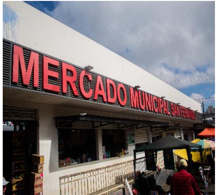
Figura 59. Mercado municipal ubicado en San Fernando, Chiapas.
