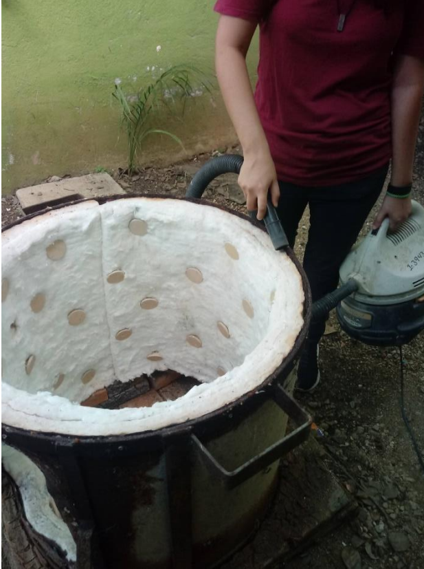
Figura 200 Limpieza de fibra cerámica
