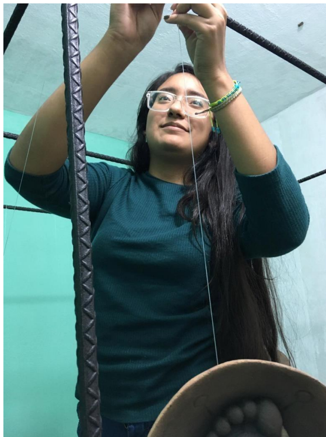
Figura 243 Colocación de los platos 2.
