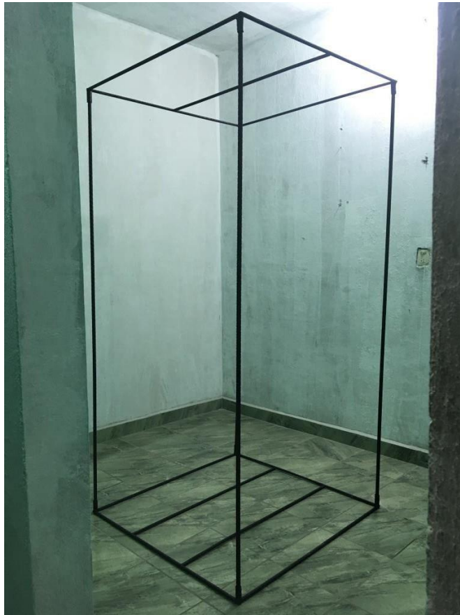
Figura 238 Vista de la estructura 2.
