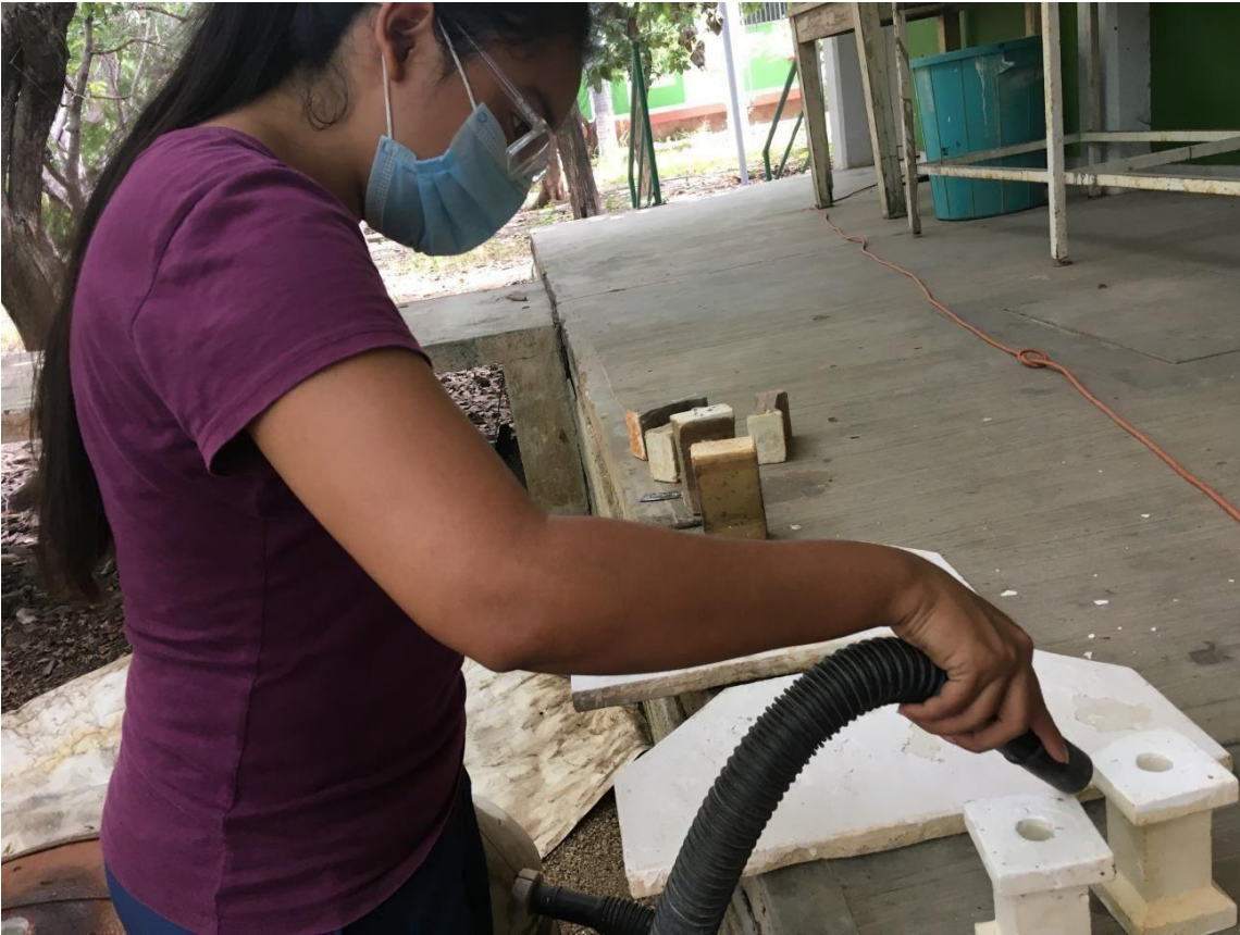
Figura 201 Limpieza de Placas térmicas
