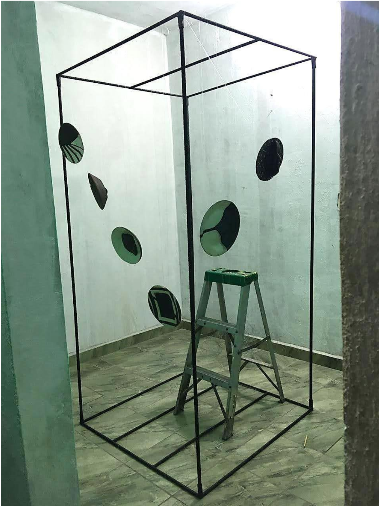
Figura 245 Avance de la instalación.
