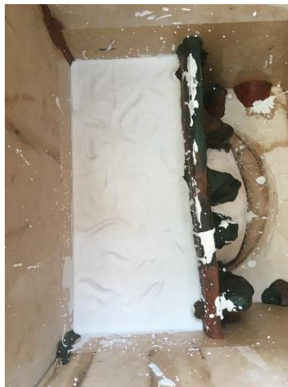
Figura 86 Vaciado de la primer mitad
