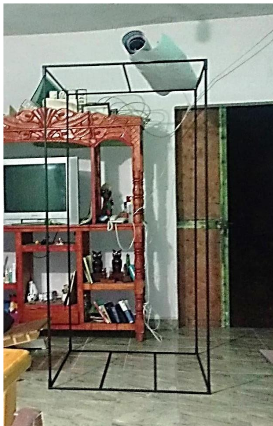
Figura 235 Estructura soldada y ensamblada.
