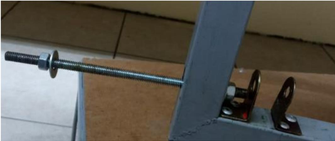
**Figura 4.18.** Bisagras y varilla en el eje cenital.
