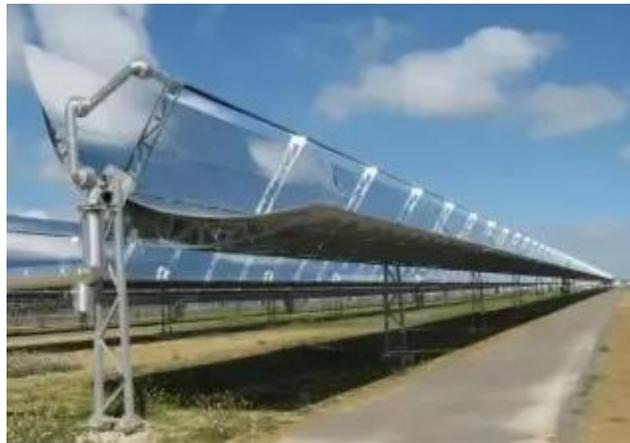
*Figura 2.6. Captadores solar cilindro-parabólico [10].*
