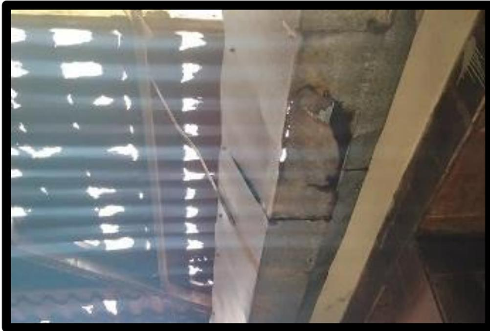
Figura 7. Canaleta de acero galvanizado.
