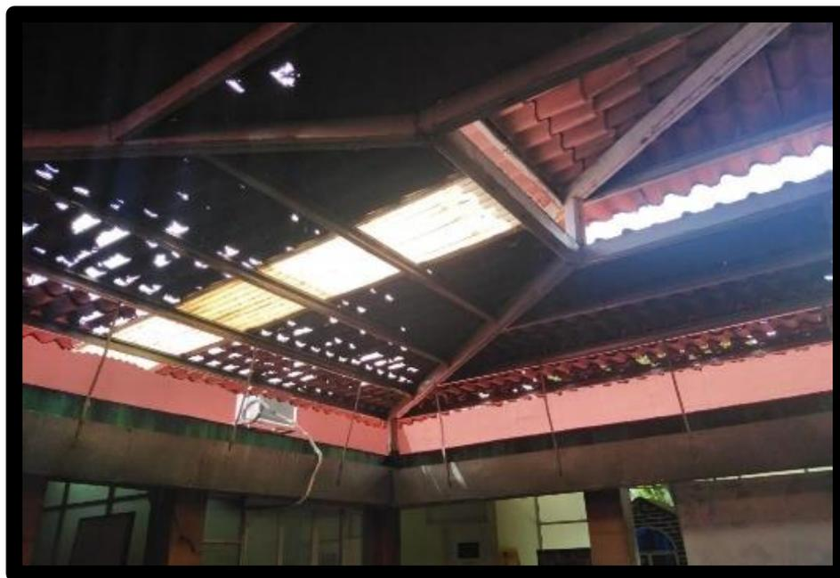
Figura 6. Techado con desprendimiento de láminas.
