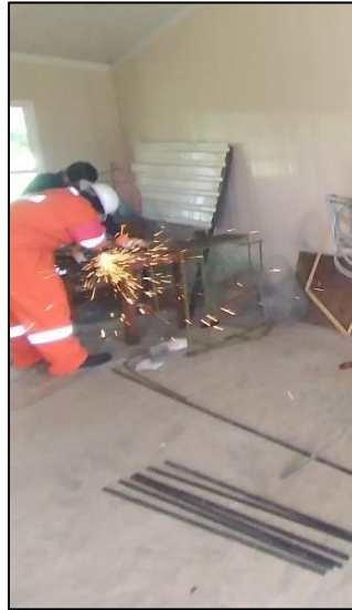
Figura 10: Taller de soldadura del plantel. (Fuente: propia del autor)
