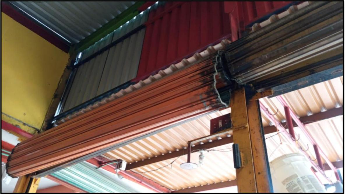
Figura 20. Cortinas en mal estado.
