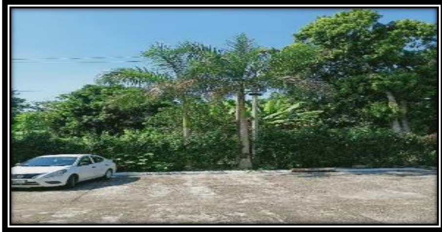
Figura 14 Arboles topando con el cable de alta tensión que alimenta a la unidad. Fuente: Con base en la información obtenida.
