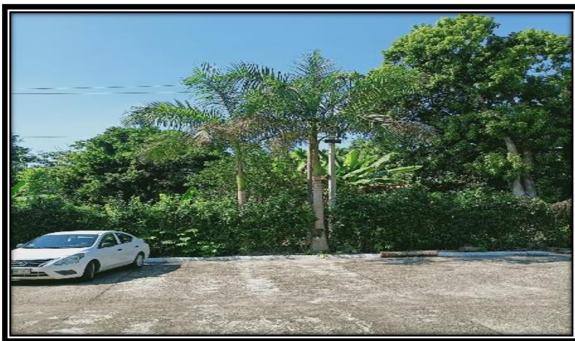
Figura 5 Árbol que topa con el cable de energía eléctrica de ECOSUR. Fuente: Con base en la información obtenida
