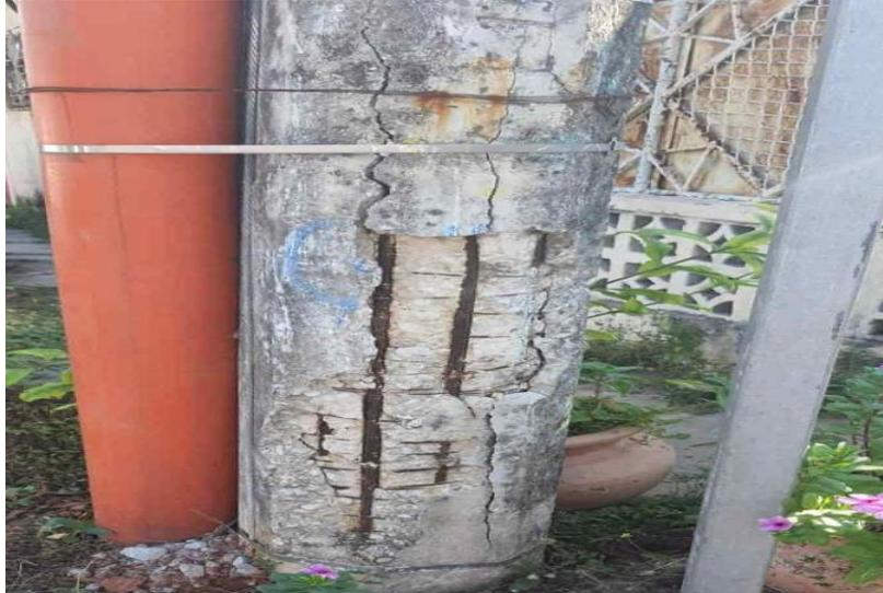
Figura 10. Poste de luz en estado de deterioro
