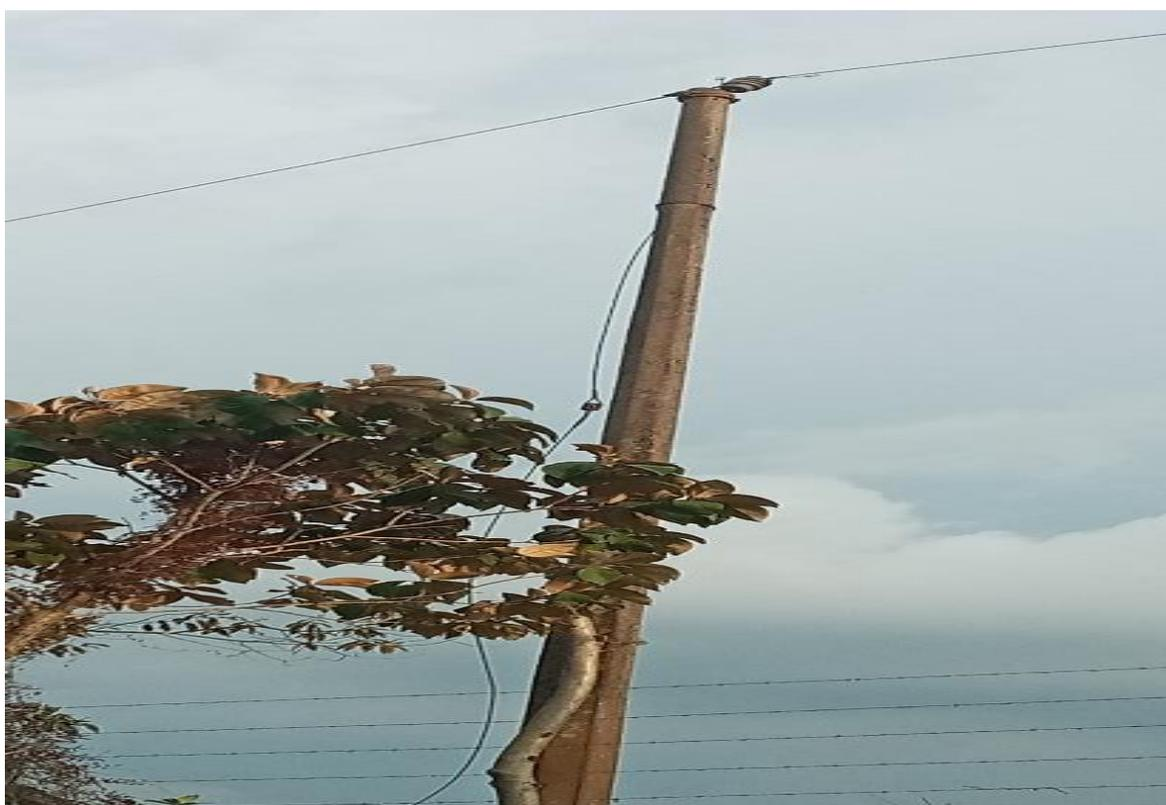
Figura 18. Cable tensor reventado
